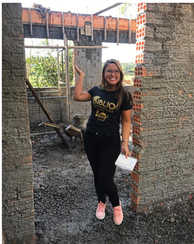
Figura 3 - Acompanhamento da construção da Biblioteca da escola
