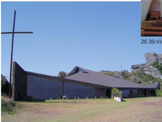
20.31-Vista fachada frontal.
