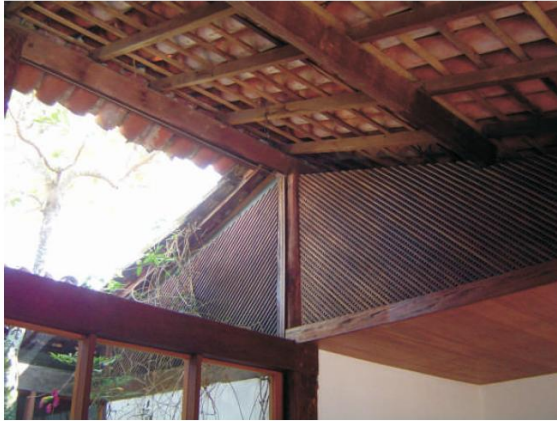
41.10-Vista D - telhado existente (em 1º plano).
