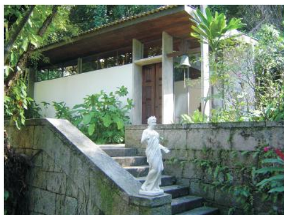
22.3-Escada de acesso ao nível da Capela.
