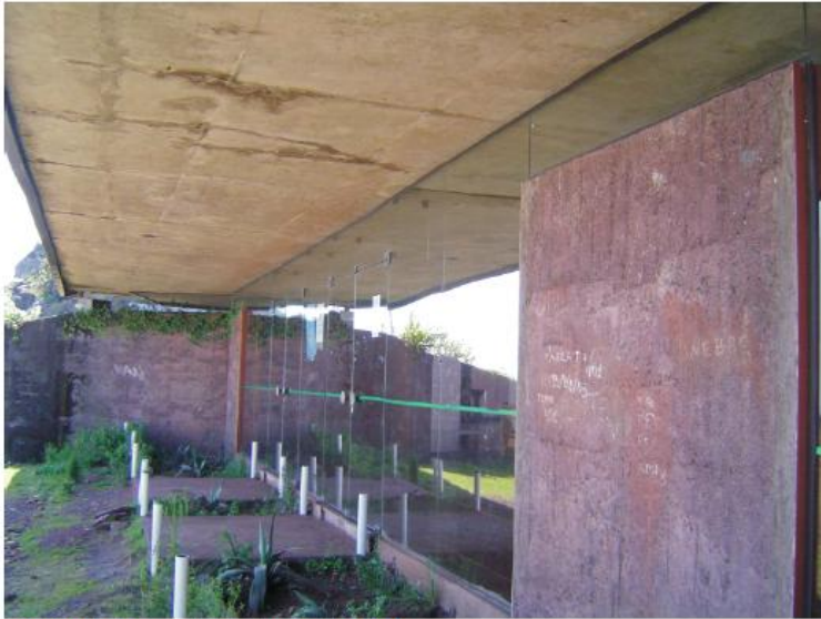
20.32-Vista parcial fachada frontal.
