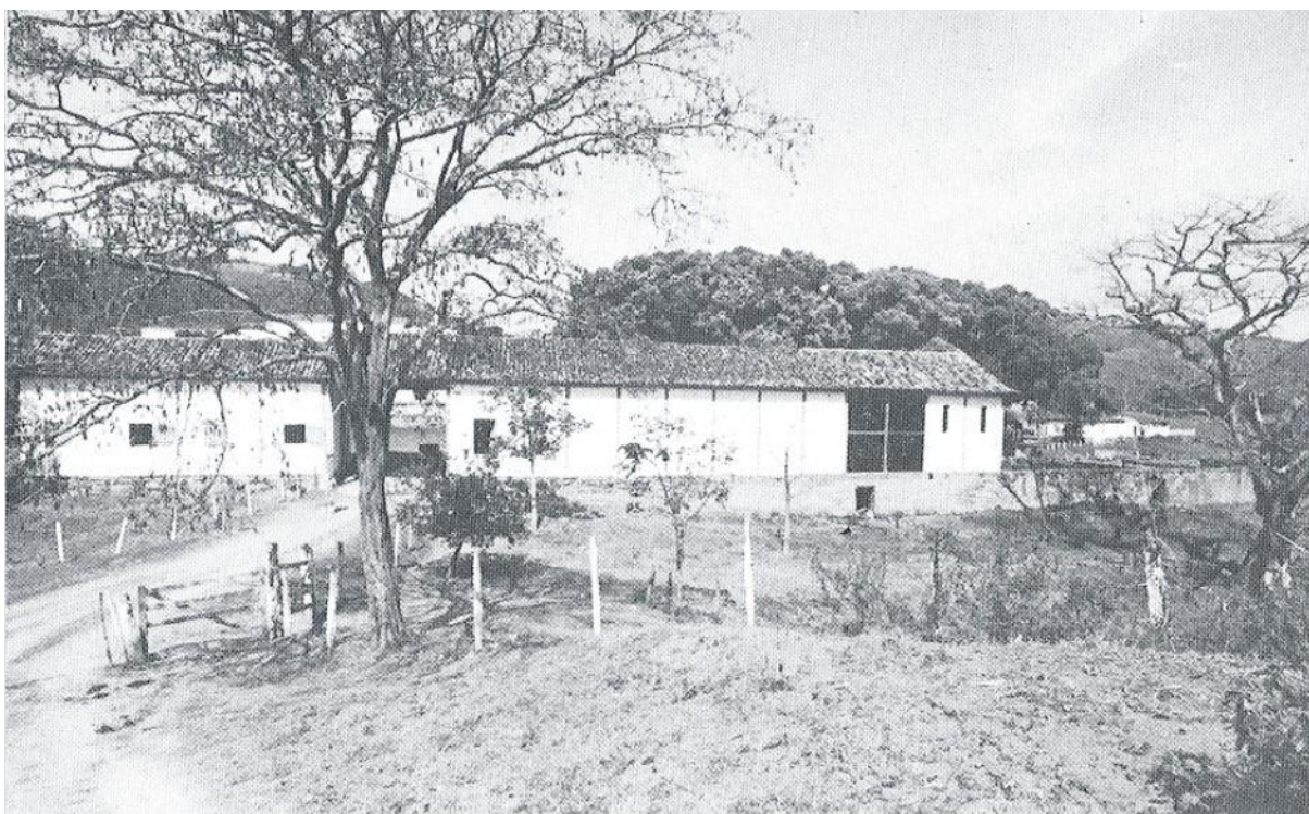
39.1-Casa de Maisa e Rodolfo de Mello - capela à direita (na fachada).
