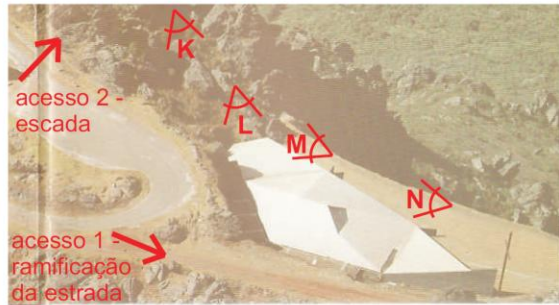
20.22-Vista aérea Igreja-Abrigo.
