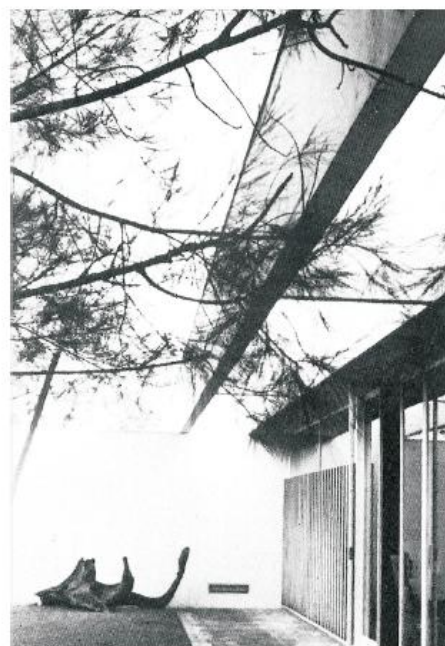
26.2-Trecho da fachada principal.
