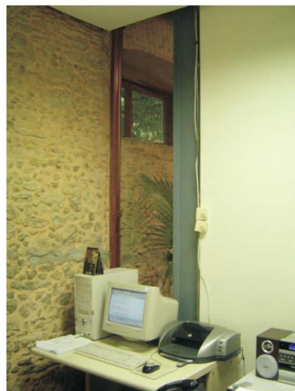
38.17-Vista 8 - encontro da divisória com parede existente.
