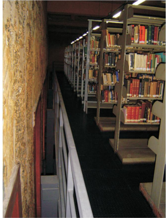
42.6-Conexão entre mezanino novo e parede existente.
