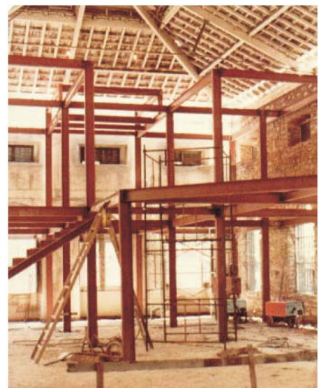
38.13-Construção dos jiras.
