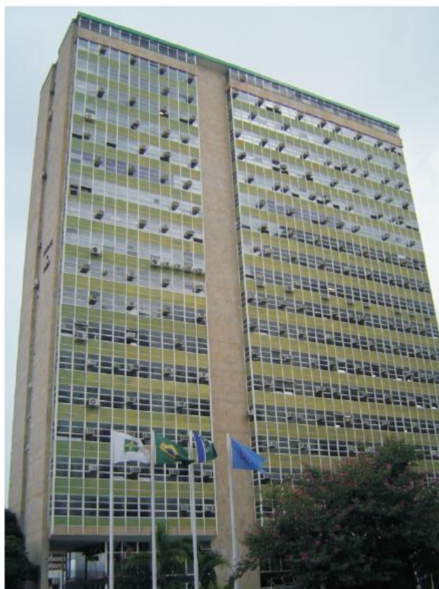
24.4-Vista A - Fachada noroeste.
