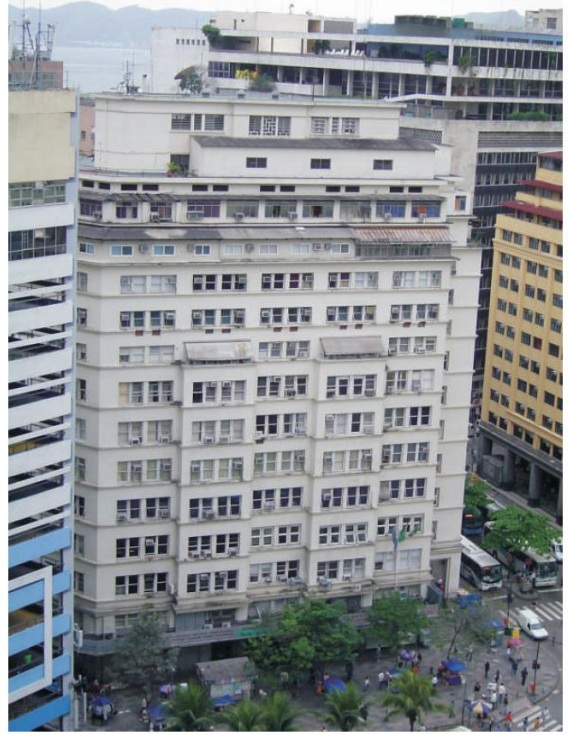
1.4-Vista B - fachada oeste.
