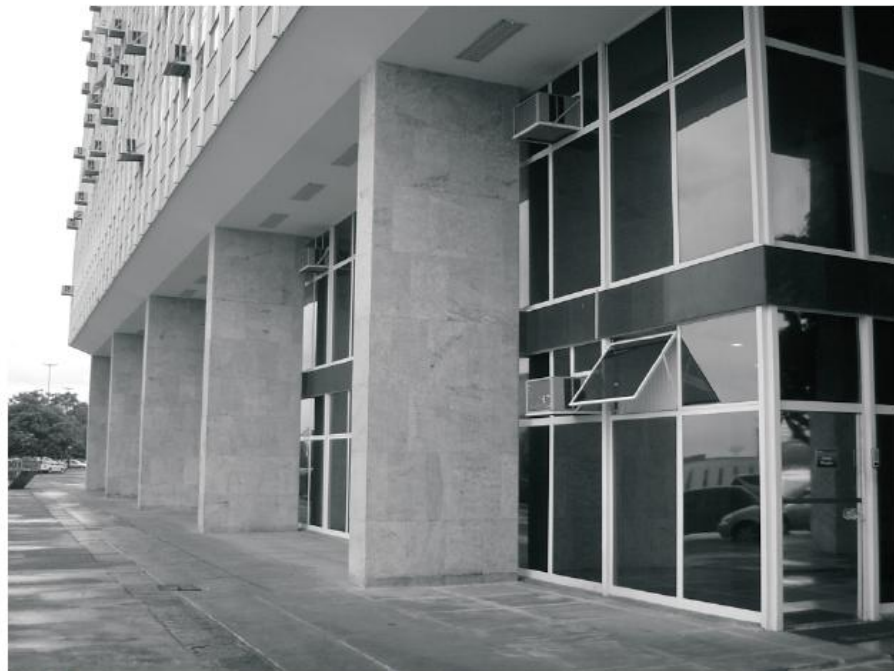
24.8-Fachada sudeste - térreo e sobreloja.
