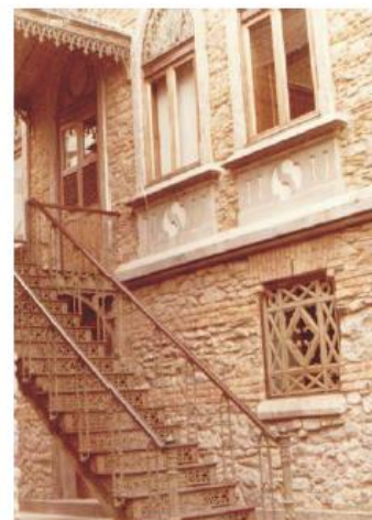
36.7-Casarão depois da intervenção.
