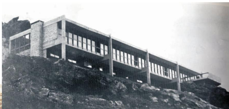
20.11-Vista fachada principal.
