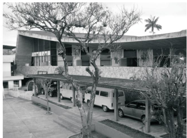
18.11-Fachada sudoeste - Igreja.
