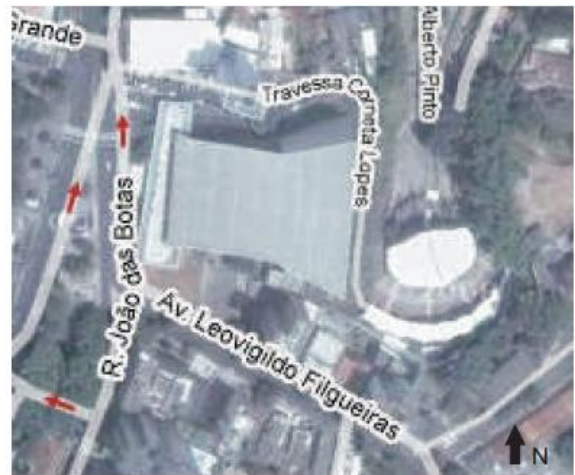
8.10-Teatro Castro Alves - Vista aérea - Proj. Bina Fonyat.
