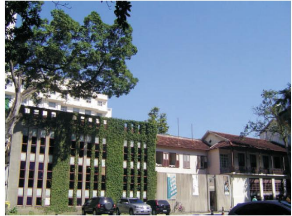
40.5-Vista 2 - Fachada do anexo (esq.) e fachada lateral CNFCP (dir.).
