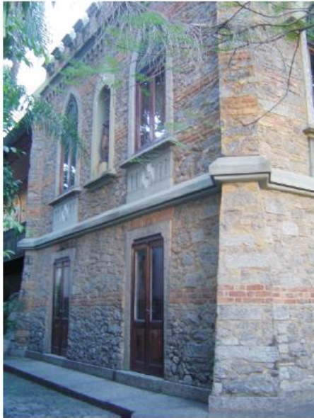
36.8-Fachada lateral - vista parcial.
