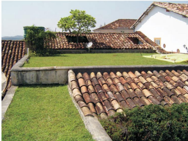
41.8-Vista dos terraços jardim e do telhado (ao fundo).
