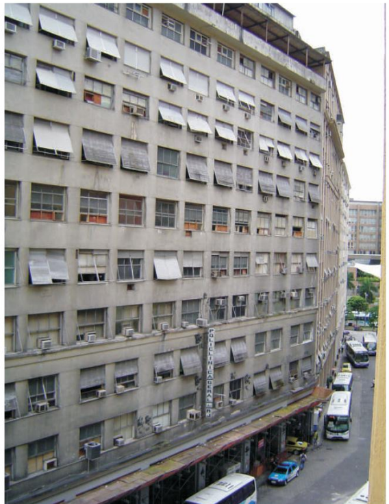
1.6-Vista D - fachada sul.
