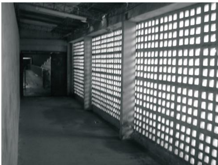
27.5-Anexo ao ginásio - vista interna.
