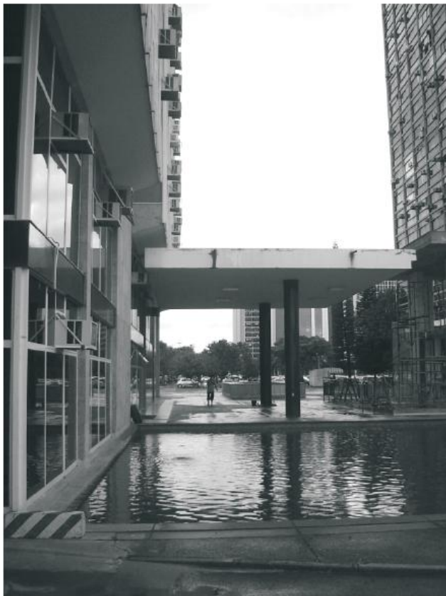
24.11-Fachada noroeste - espelho d'água (1º plano) e marquise do acesso principal (2º plano).
