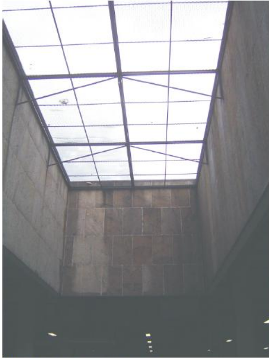
24.9-Vista interna zenital subsolo.
