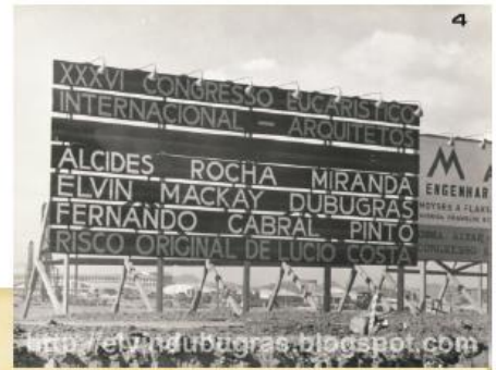
16.1-Placa de identificação da obra.
