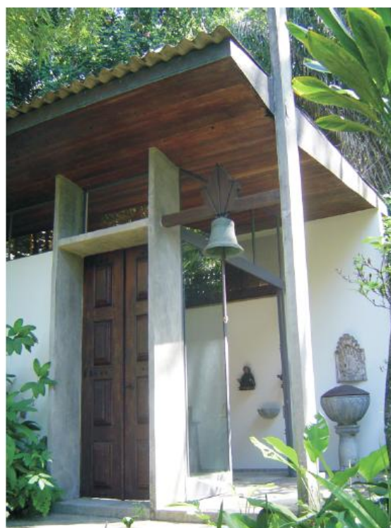
22.4-Vista dos dois acessos à Capela.
