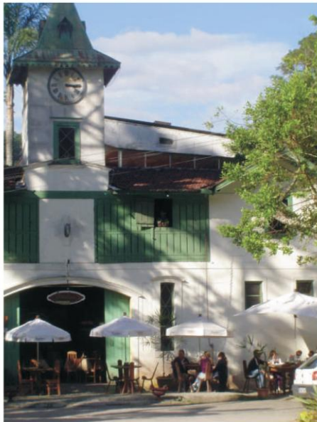
6.34-Cocheira e parte da cobertura da Casa Celso (ao fundo).
