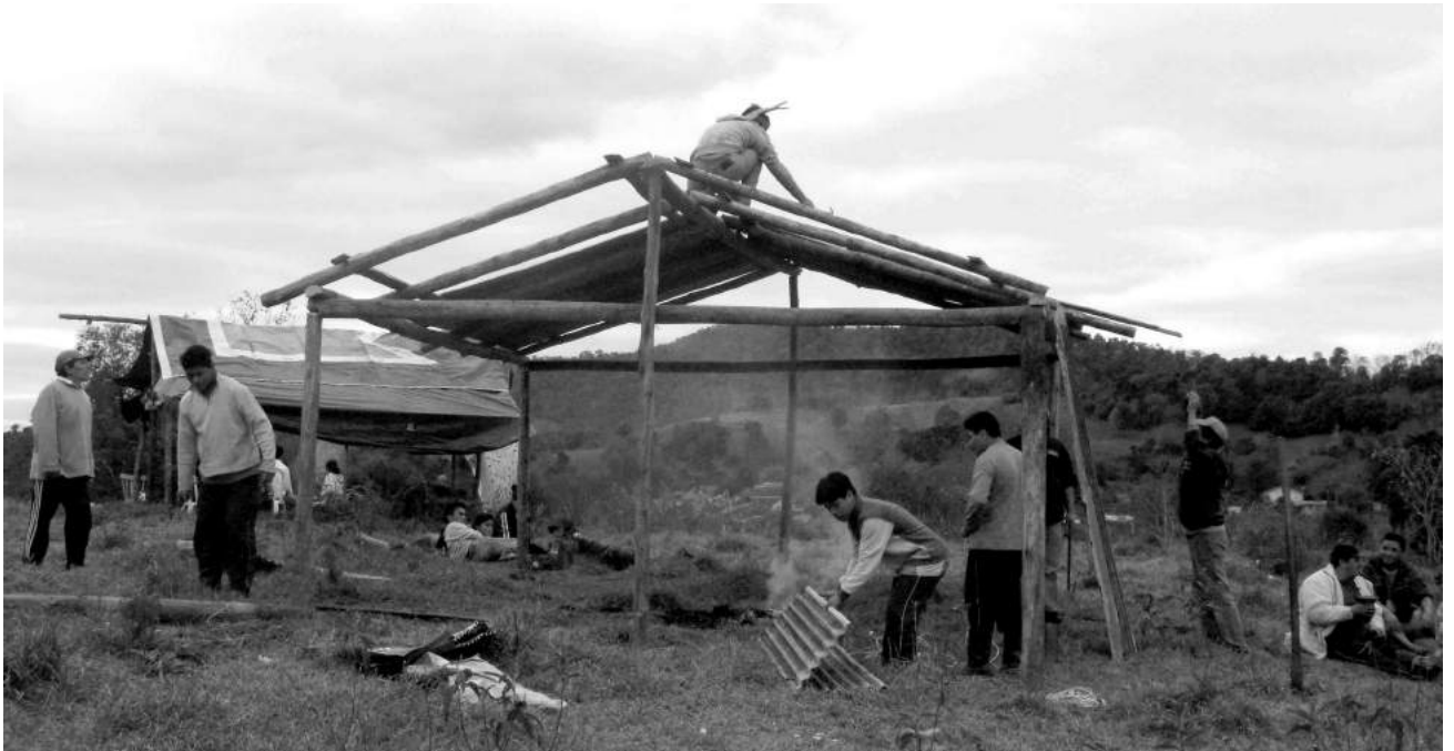
Fotografia 128. Construção de uma casa no território recuperado. TI Kanhgág ag Goj, julho de 2016 - Clémentine Maréchal.
