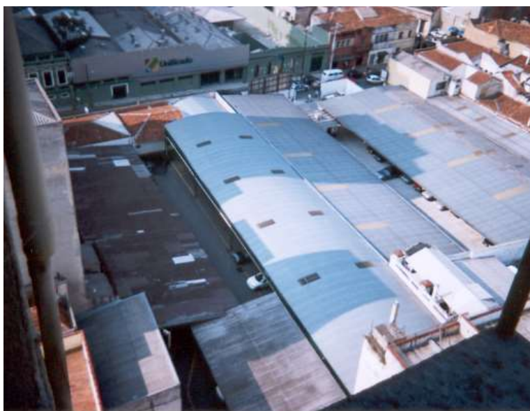
FIGURA 233 : Foto II tirada da janela da escada de serviço de um edifício o centro de quarteirão n°9, na Rua Barão do Serro Azul (à esquerda).
