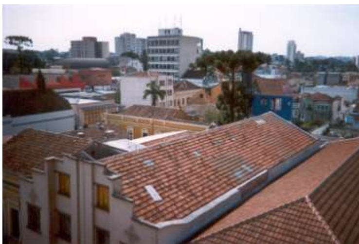
FIGURA 226 : Foto tirada do Mirante da Casa da Memória para o centro de quarteirão nº7. Fonte : Foto tirada pela autora em setembro de 2001.
