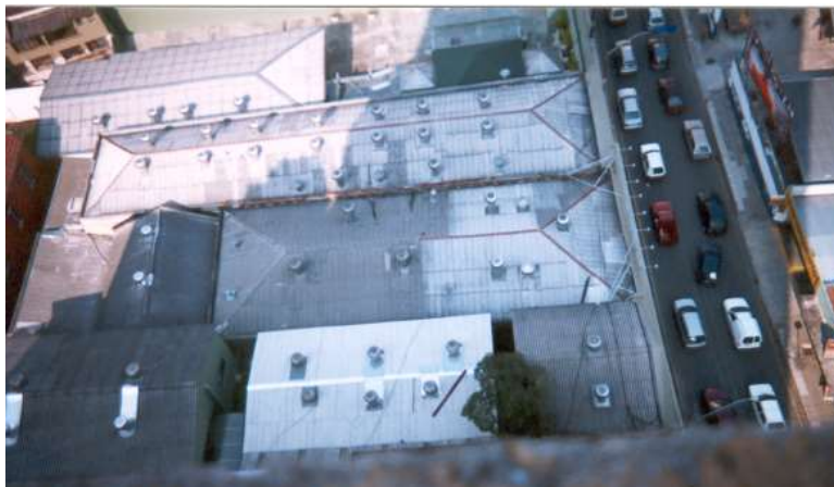
FIGURA 229 : Foto tirada da janela da escada de um edifício do centro de quarteirão nº8, na Rua Treze de Maio esquina com Barão do Serro Azul. Fonte : Foto tirada pela autora em setembro de 2001.
