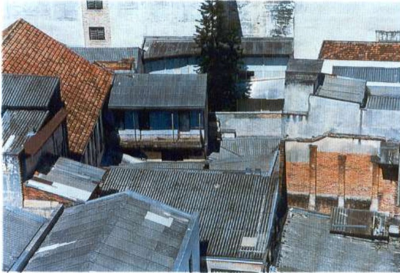
FIGURA 201 : Os “puxados” sobre os centros de quarteirão em Curitiba. Não há ventilação nem iluminação dos edifícios originais.
