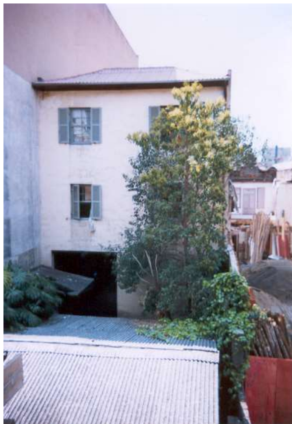
FIGURA 216 : Foto II tirada da janela de uma obra no centro de quarteirão nº4 , na Rua Dr. Muricy. Fonte : Foto tirada pela autora em setembro de 2001.
