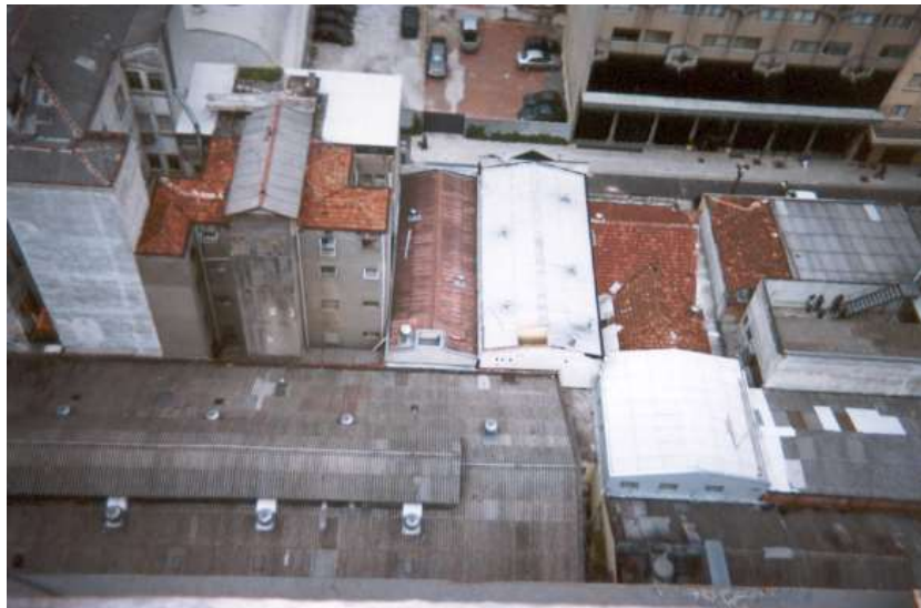
FIGURA 209 : Foto olhando de cima de um dos edifícios do centro de quarteirão nº2, na Rua Voluntários da Pátria. Fonte : Foto tirada pela autora em setembro de 2001.
