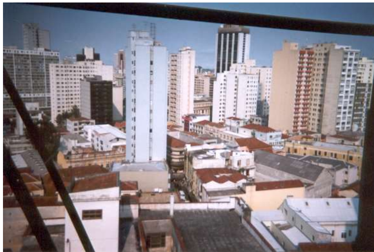
FIGURA 235 : Foto IV tirada da janela da escada de serviço de um edifício no centro de quarteirão n°9, na Rua Barão do Serro Azul (à direita).
