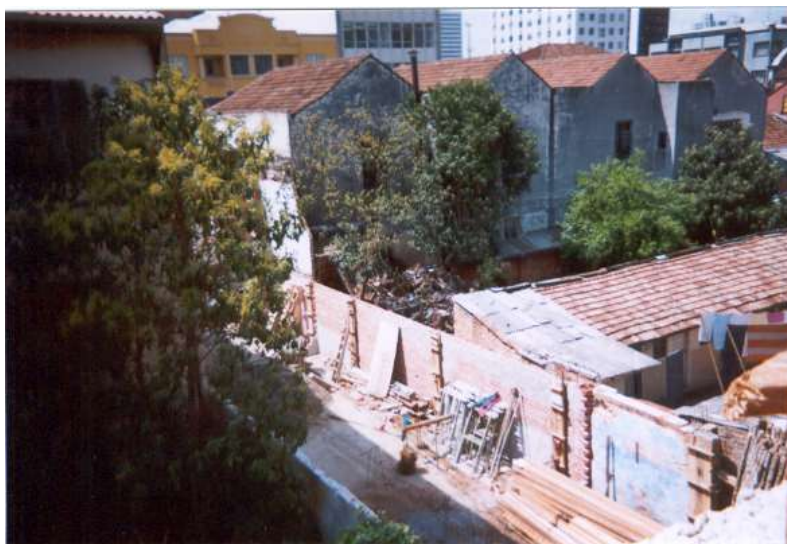
FIGURA 217 : Foto III tirada da janela de uma obra no centro de quarteirão n°4 , na Rua Dr. Muricy. Fonte : Foto tirada pela autora em setembro de 2001.
