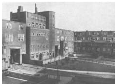
FIGURA 55 : Vista do pátio de um edifício com centro comercial em Rotterdam. Projeto de M. Brinkmann.
