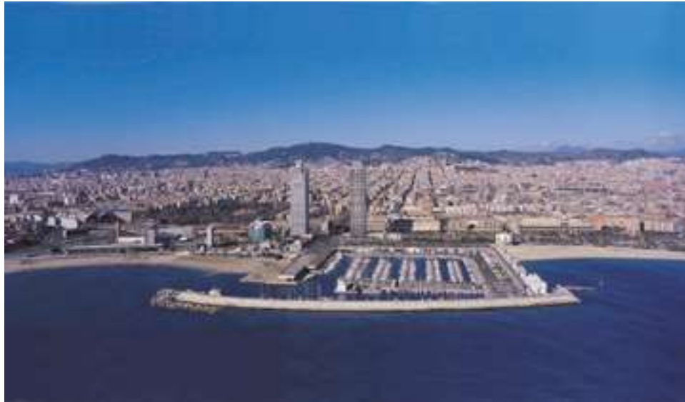
FIGURA 170 : Foto aérea de Barcelona vista do mar. Fonte: Site: www.bcn.es .
