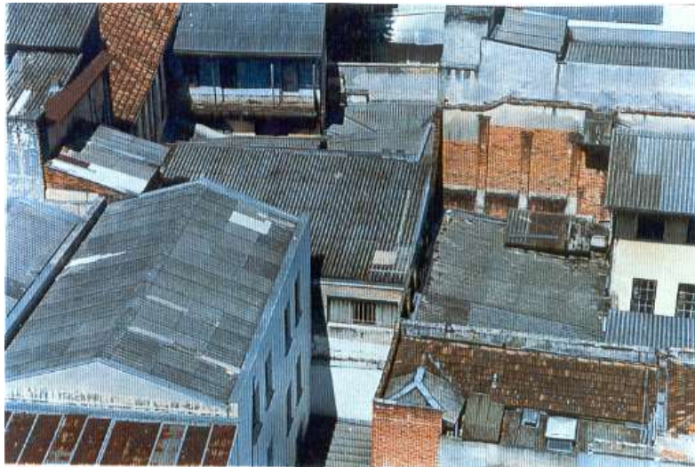
FIGURA 202 : Exemplo de ocupação caótica nos centros de quarteirão em Curitiba.
