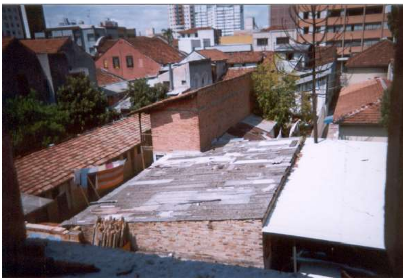
FIGURA 215 : Foto tirada da janela de uma obra no centro de quarteirão nº4 , na Rua Dr. Muricy. Fonte : Foto tirada pela autora em setembro de 2001.
