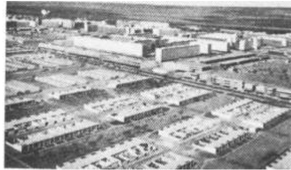
FIGURA 66 : Edifícios residenciais em Brasília. Fonte : KRIER, Rob. Urban Space.
