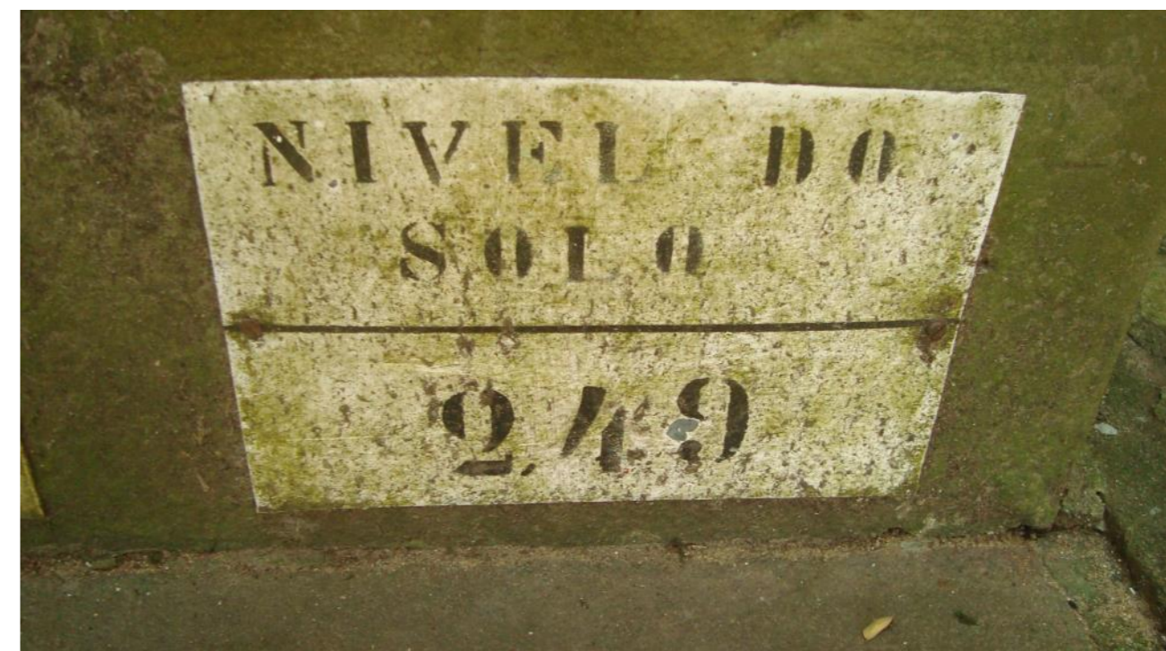
NÍVEL DO SOLO EM CAIXA D'ÁGUA NA SEDE DO GRÊMIO NAÚTICO UNIÃO NA ILHA DO PAVÃO
