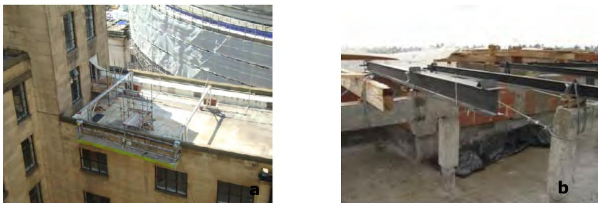
**Figura 3-3-4.** (a) Sistema modular para sustentar andamios suspendidos; (b) Vigas de hormigón armado especialmente proyectadas para el apoyo de perfiles que sujetan el andamio
