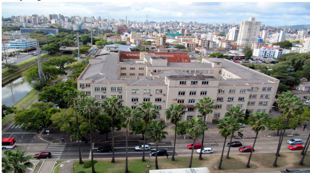
Figura 3 - Palácio da Polícia de Porto Alegre, Av. João Pessoa. A esquerda na foto está a Av. Ipiranga, onde se localiza a 2ª DPPA
