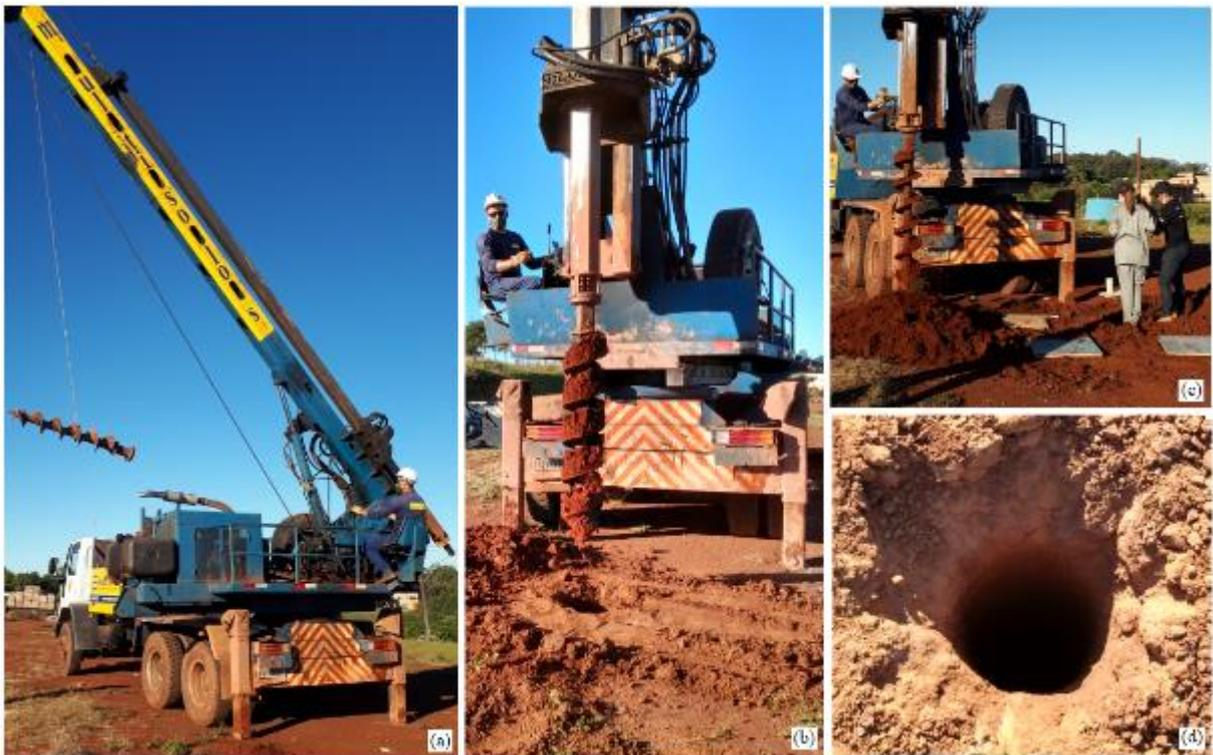
Figura 3.13. (a) Perfuratriz montada sobre caminhão – broca de 30 cm de diâmetro, (b) Perfuração do solo com broca rotativa, (c) Conferência da profundidade com barra guia e (d) Furo concluído
