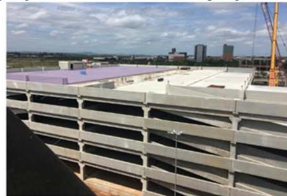
(e) atraso no início do capeamento e aumento do tamanho do lote
