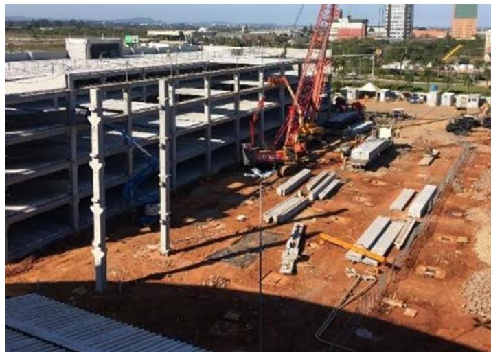
Figura 9 - Estoque de peças em obra
