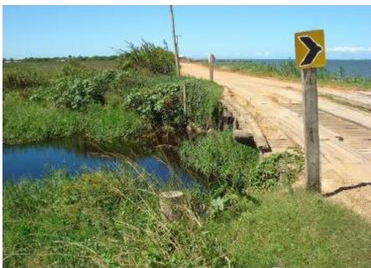
Figura 19: Ponte de acesso à Colônia de Pescadores Z3, sobre o canal Reasilva. Fonte: Dellamare et al. 2015
