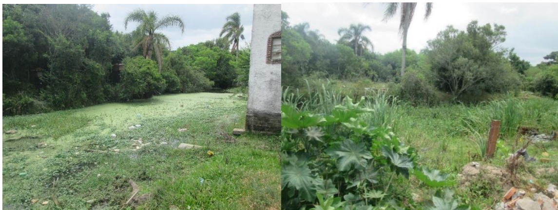
Figura 17 e 18: o canal da foto 15, porém em outro ângulo. Esta foto foi tirada dos fundos da igreja da Assembleia de Deus, Rua Idomar São Batista. Fonte: da autora.
