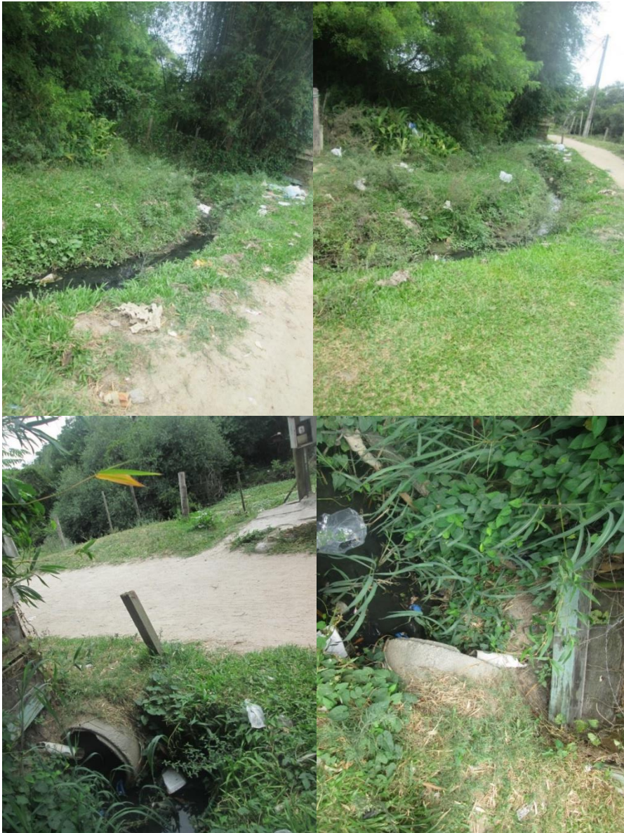
Figura 13 e 14: valeta aberta, Rua Idomar São Batista. Segundo ele, aqui também tinha um canal, que foi aterrado. Ele contou que aqui tinha outro pontilhão para a passagem das pessoas. Fonte: da autora.
