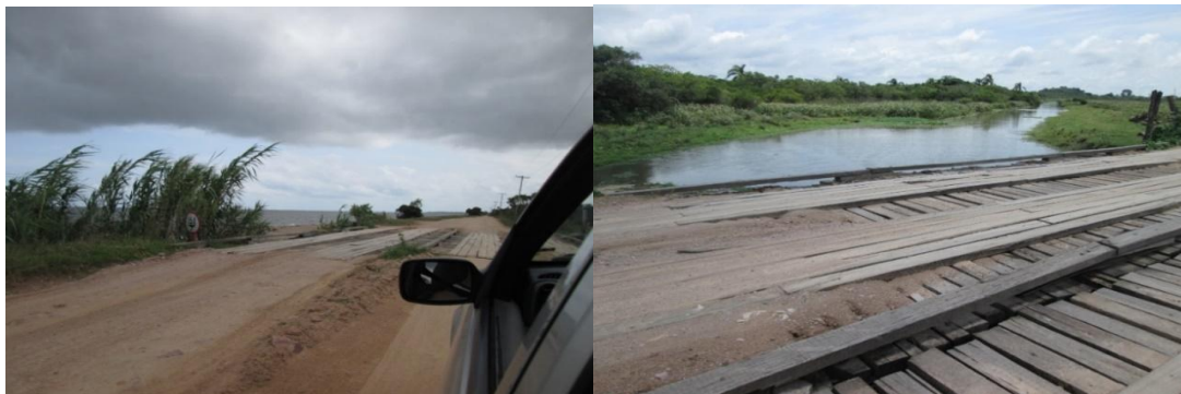
Figura 40: Fotos da ponte sobre o Arroio Sujo, na estrada de acesso à Z3, na Rua Rubens Souto, onde os moradores relatam de alagamento, foto retirada da ponte que inicia o alagamento
