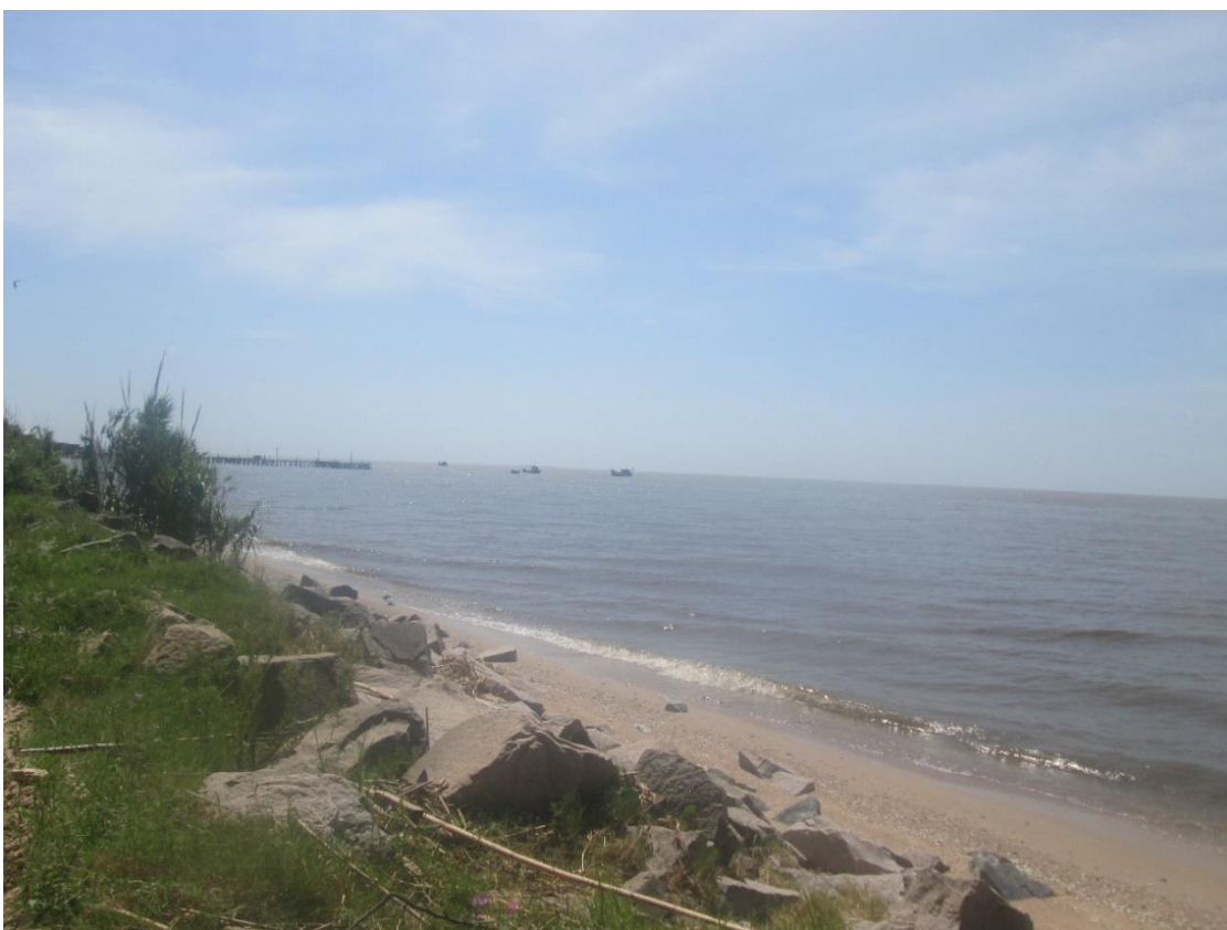
Figura 68: Parte da barreira de pedras, na entrada da Colônia Z3
