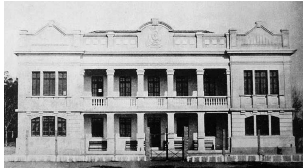
Inauguração da escola em 1927 | Relatório da Secretaria de Obras Públicas
