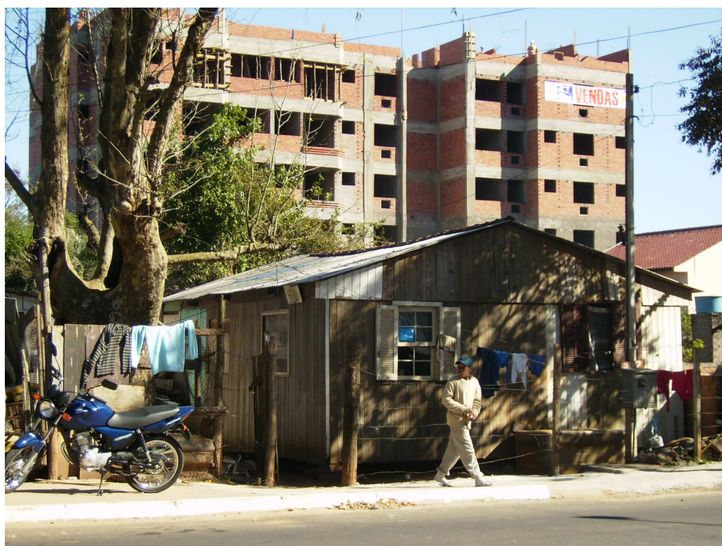
Entrada da Chácara das Rosas a partir da Rua Dona Rafaela, com prédio em construção ao lado. Foto: Vinicius Oliveira - Agosto de 2006.
