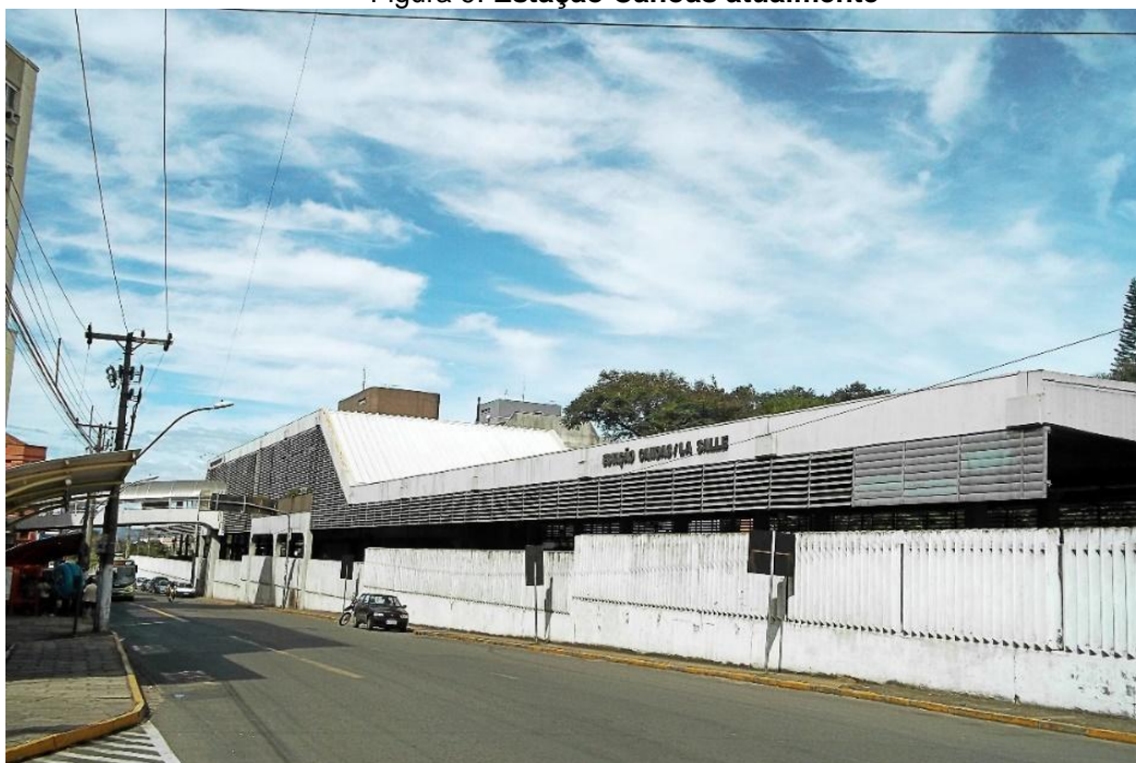
Figura 9: Estação Canoas atualmente
