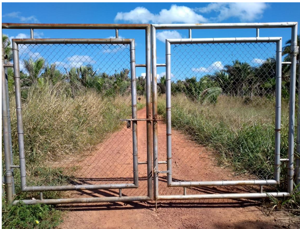
Figura 7 - Portão instalado na entrada da comunidade Demanda
