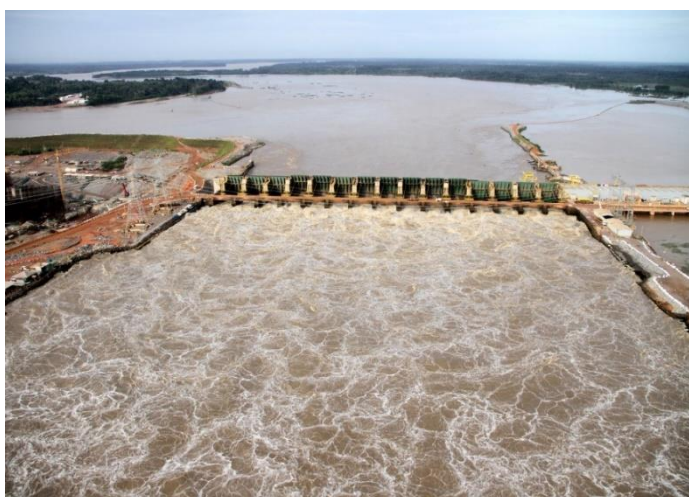
Figura 1.3 - Foto aérea do vertedouro principal da UHE Santo Antônio em operação.
