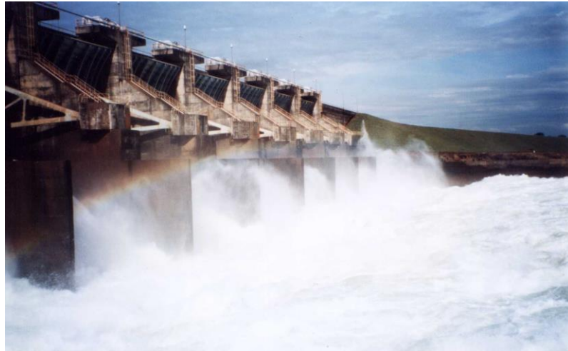
Figura 2.2 – Ressalto hidráulico formado na bacia de dissipação da UHE Porto Colômbia, Brasil, Teixeira (2008).
