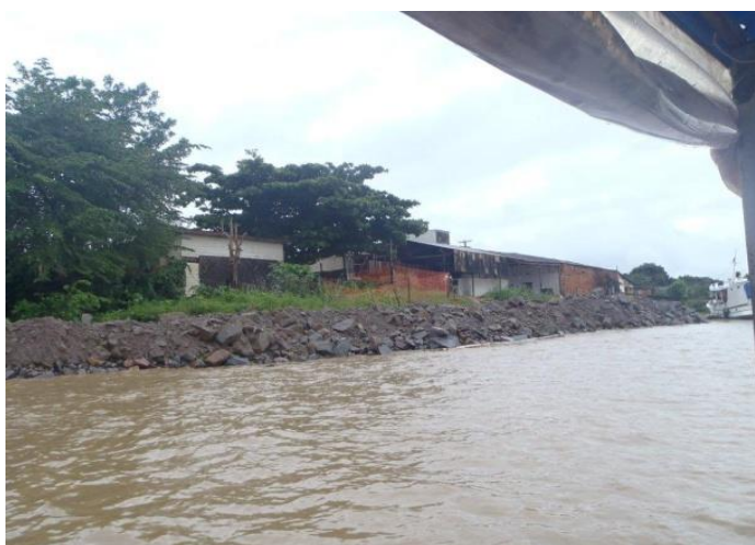
Figura 1.4 - Enrocamento lançado no bairro Triângulo para a proteção de margens.
