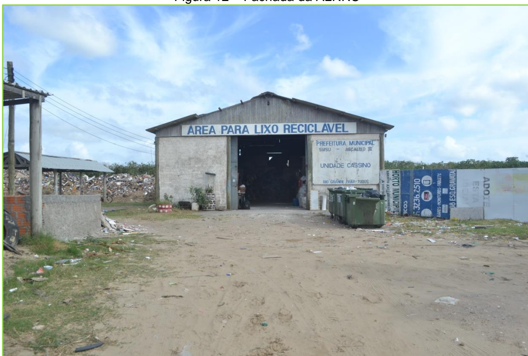
Figura 12 – Fachada da ALRRC
