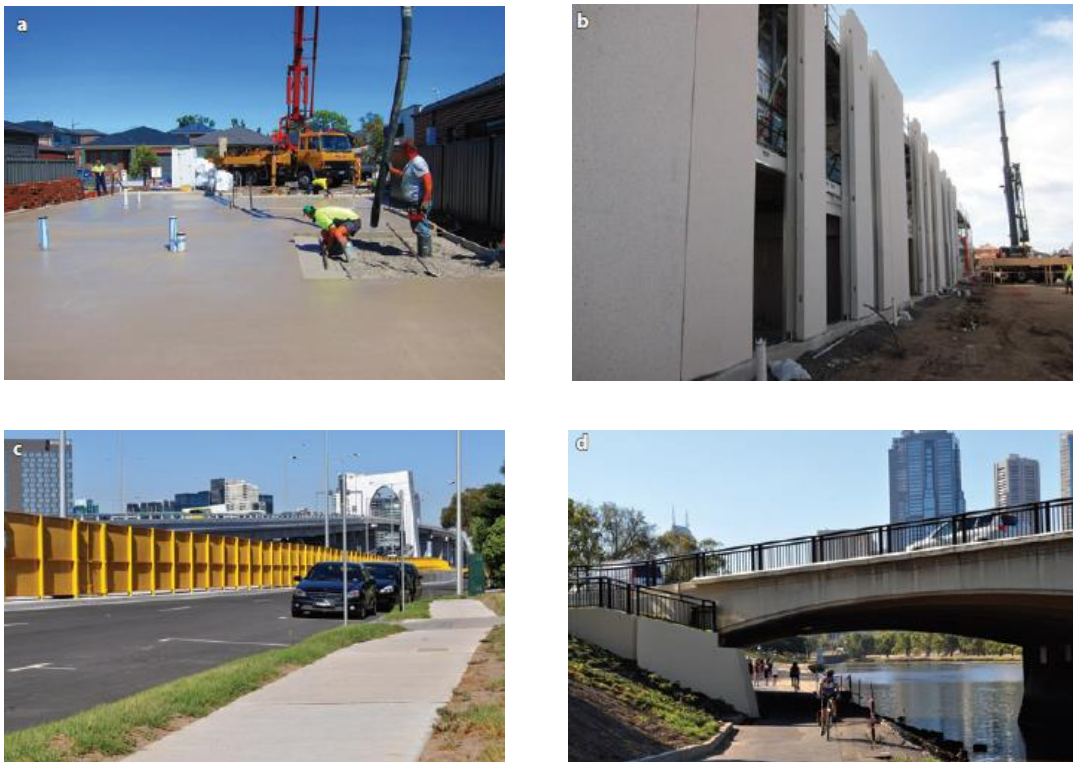
Figura 2.2- Uso do concreto álcali ativado E-Crete na Austrália.
