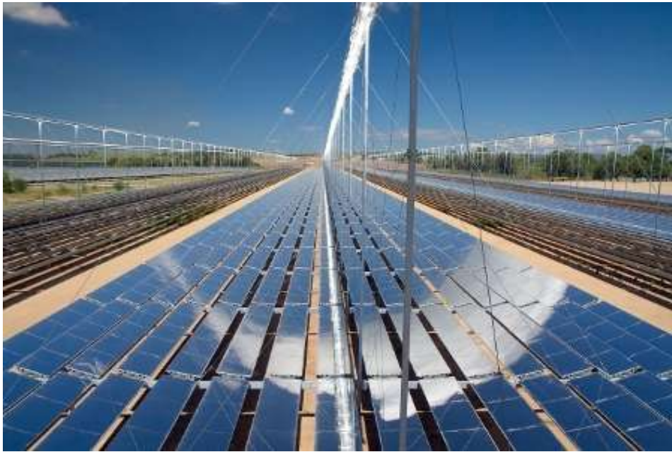
Figura 2.2 - Conjunto de coletores linear Fresnel, absorvedor e refletor secundário [SolarPACES, 2020].
