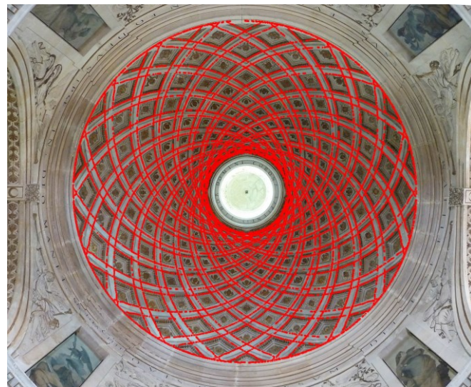
Fig. 53. Capela Real de Anet, após 1547, Philibert de l'Orme. Fotomontagem do esquema de geração das curvas na cúpula segundo Robin Evans sobre fotografia. Fontes: 1) fotografia: https://commons.wikimedia.org/wiki/File:Ch%C3%A2teau_d%27Anet_-_Anet_-_Eure-et-Loir_-_France_-_M%C3%A9rim%C3%A9_PA00096955_(52).jpg 2) desenho do autor a partir de modelagem digital em Sketchup e finalização em Photoshop .
