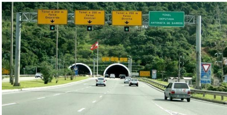
Figura 5 - Túnel Deputada Antonieta de Barros 66
