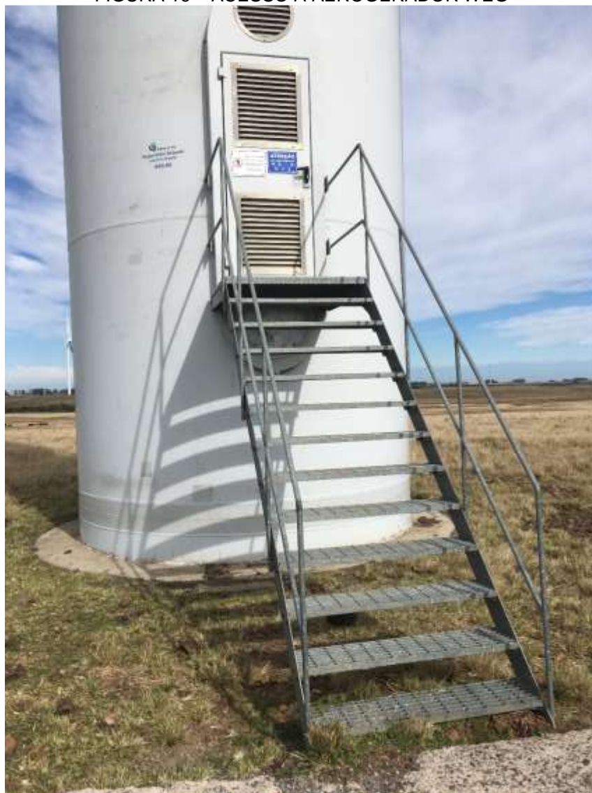
FIGURA 16 – ACESSO À AEROGERADOR WEG
