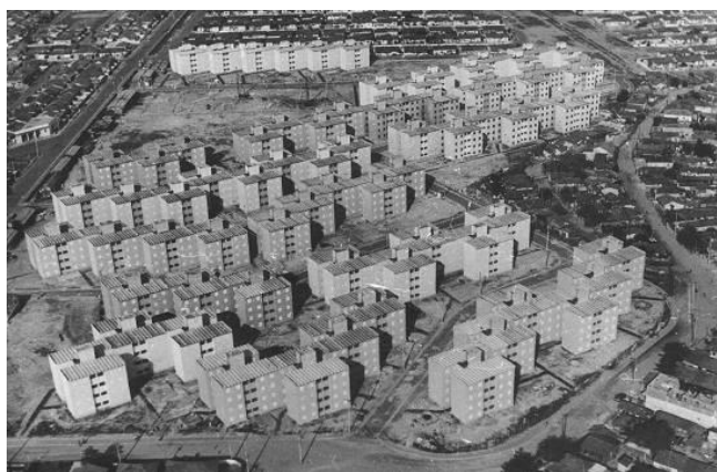
Figura 9. Fotografia aérea de um conjunto habitacional financiado pelo BNH
