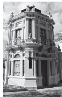
Castelinho já foi restaurado
