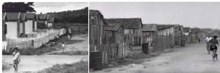
Fotos 30 a e b. À direita (a) casas removidas e reconstruídas, a esquerda (b) unidades novas financiadas
