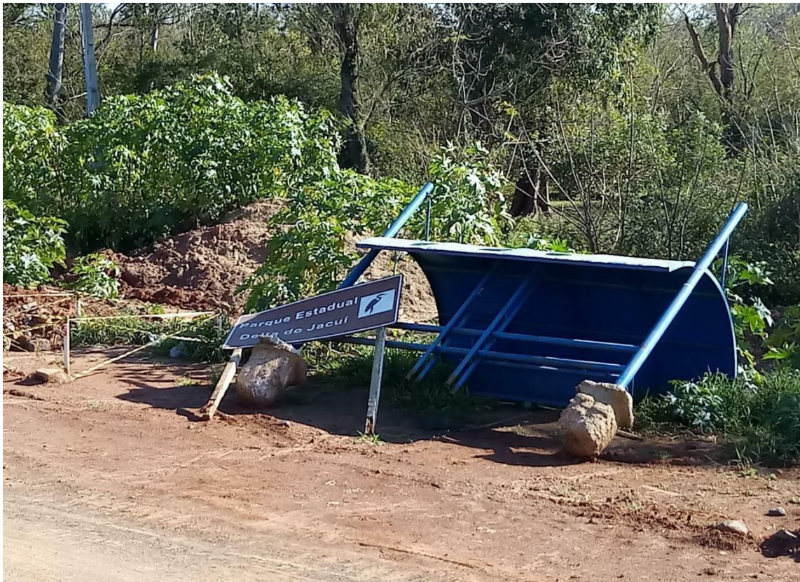
Fig.20: Placa indicativa do Parque na obra da ponte
