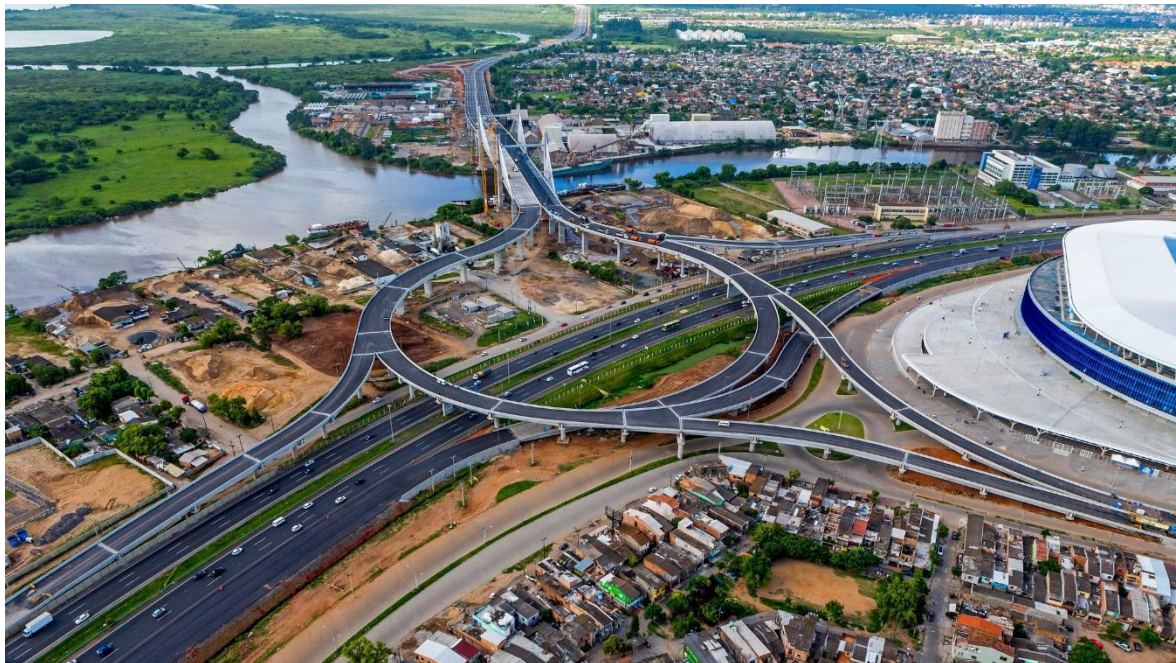
Fig.9: Vista parcial da conexão da BR 448 e BR290
