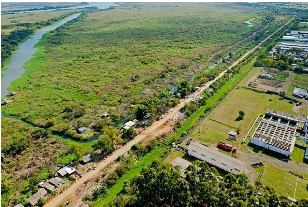
Fig.8: Visão parcial da comunidade Vila Dique antes da construção
