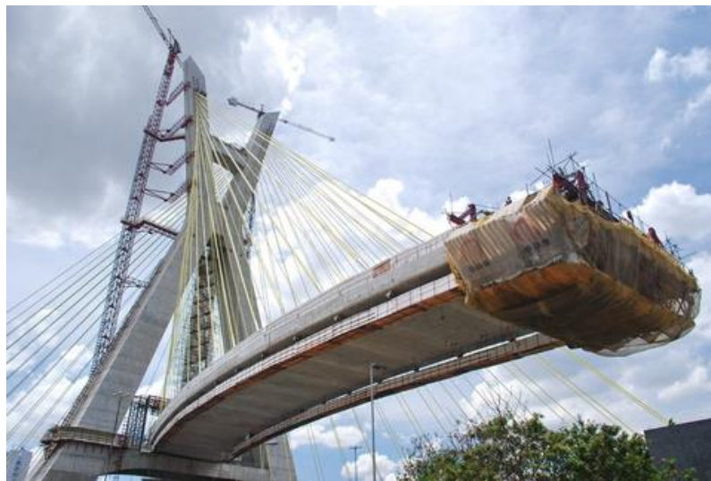
Figura 3.4 – Construção da Ponte Octávio Frias de Oliveira, em São Paulo/Brasil.
