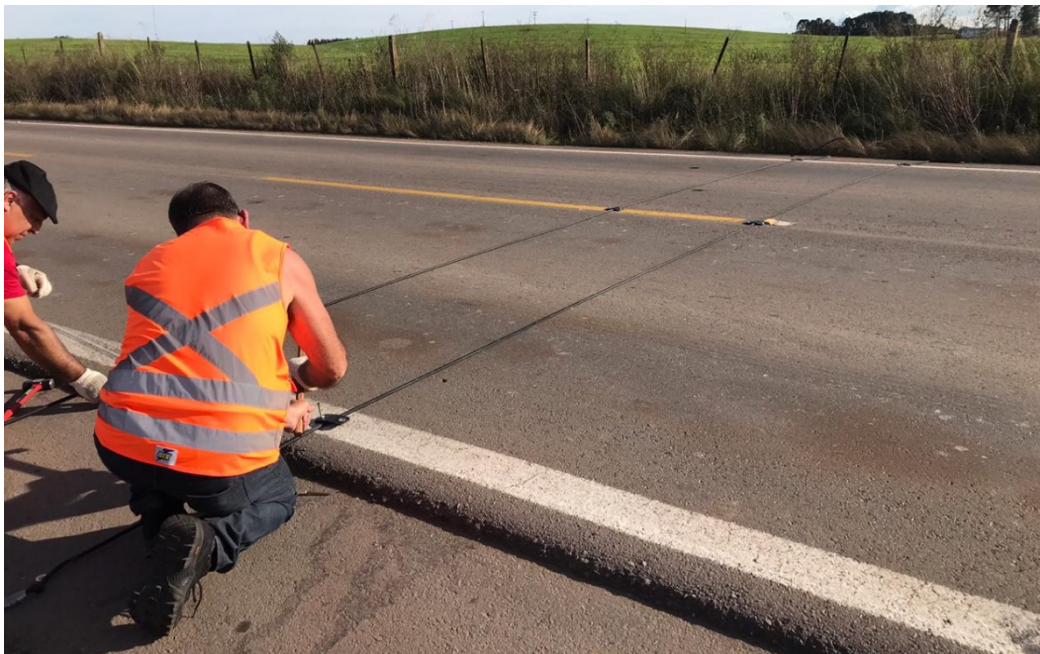
Figura 17 - Instalação dos tubos pneumáticos
