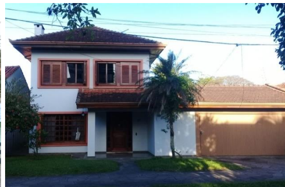
Figura 23: Travessa Antilhas, 65 – 2ª residência
