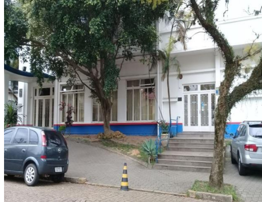
Figura 74: Alterações na fachada
