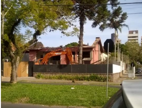
Figura 67: Residência em demolição na Avenida Panamericana
