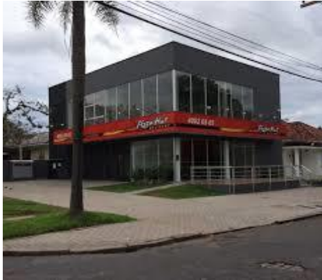
Figura 63: Praça Libaneza esquina Av.Montreal - casa demolida e construção da Pizza Hut
