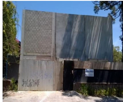
Figura 68: Construção padrão Panvel no local da residência demolida
