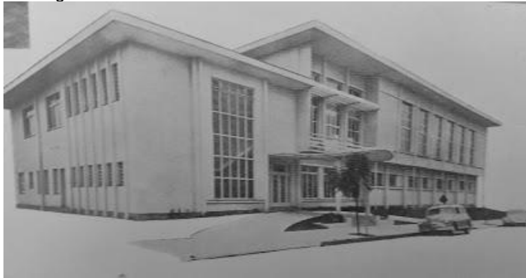
Figura 33: Fachada do Prédio do Lindóia Tênis Clube
