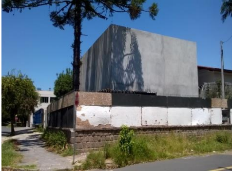
Figura 69: Outra vista da construção
