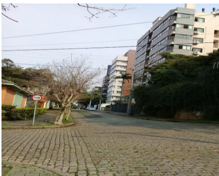
Figura 61: Os primeiros edifícios na Rua Caracas
