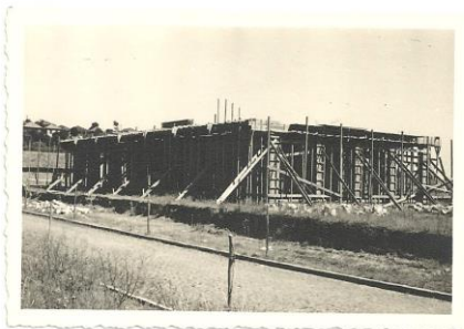
Figura 34: Construção inicial da sede do clube
