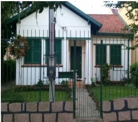
Figura 24: Av. Quito, 106 – 3ª residência
