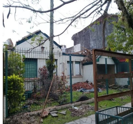
Figura 64: Praça Libaneza, residências em demolição
