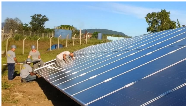
Figura A.13 – Fixação de módulos fotovoltaicos sendo realizada pela equipe técnica.
