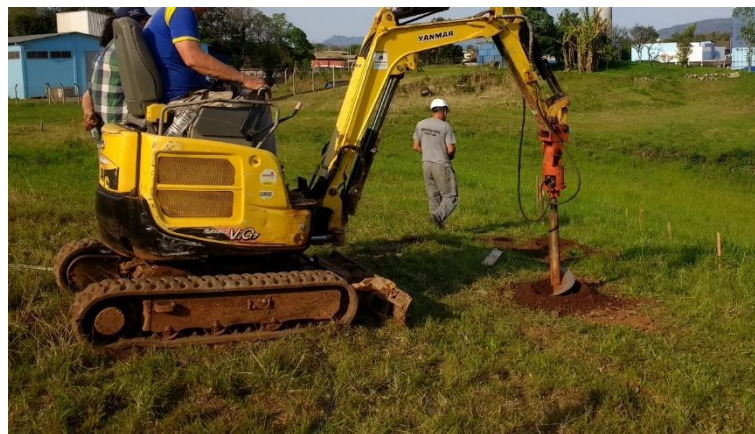
Figura A.5 – Perfuração do solo para fundações tipo estacas.
