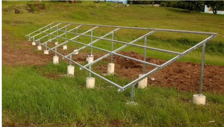
Figura A.11 – Fixação da estrutura metálica sobre fundações tipo estaca.
