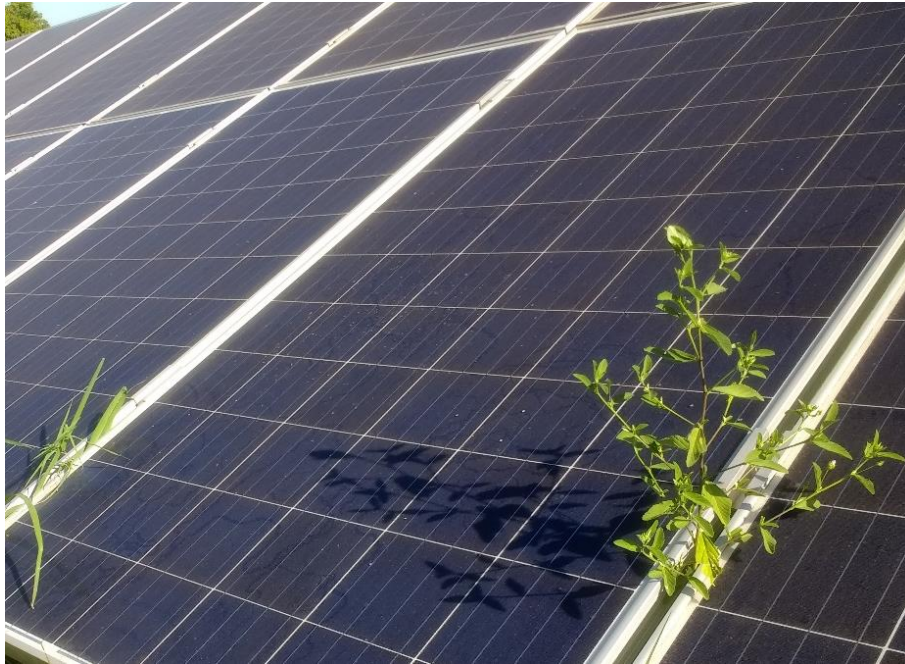
Figura 6.14 – Sombreamento causado por vegetação.
