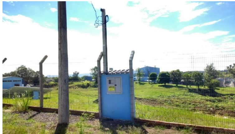
Figura A.4 – Ramal de entrada concluído.
