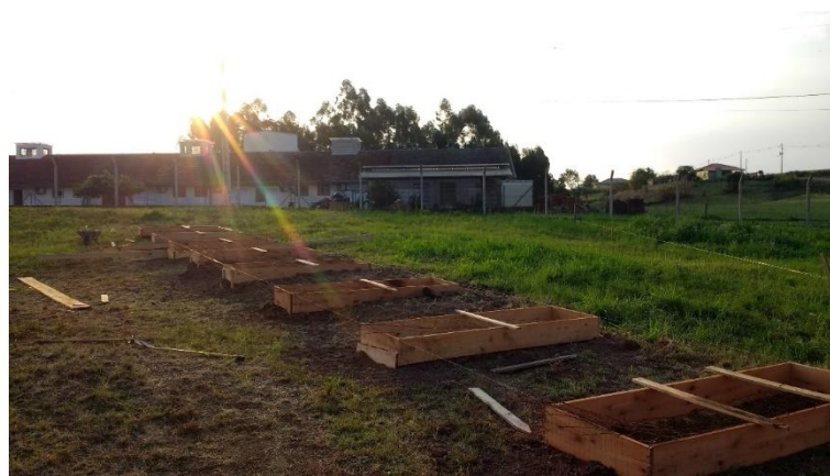
Figura A.6 – Montagem dos moldes para fundações tipo sapata associada.
