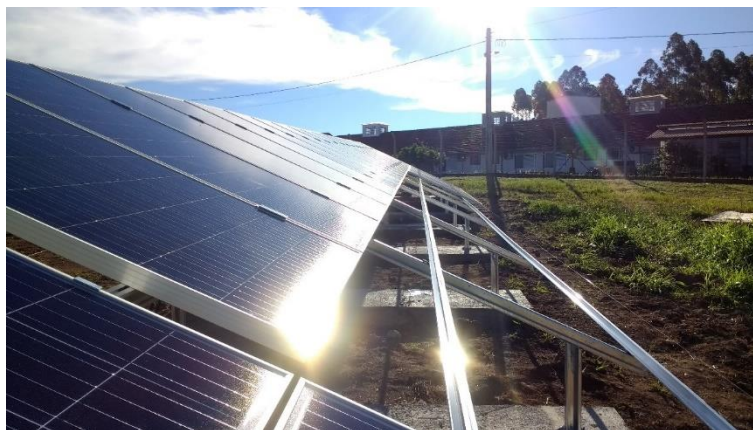
Figura A.12 – Módulos fotovoltaicos parcialmente fixados.
