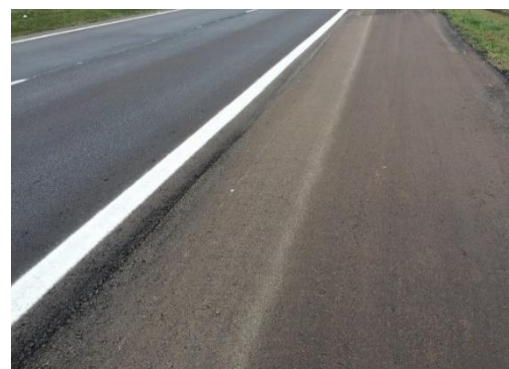
(h) Finalização do acostamento.
