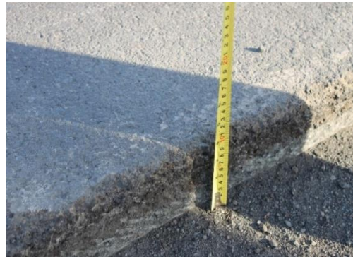
(b) Verificação da espessura.
