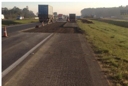
(a) Fresagem e limpeza.
