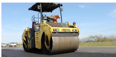
(e) Compactação com rolo chapa.
