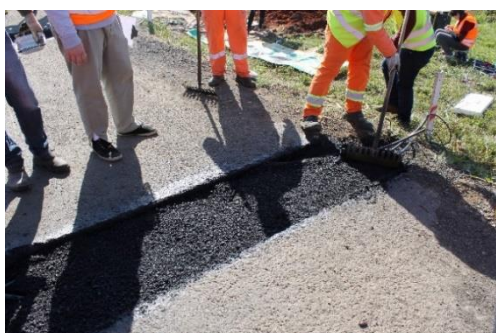
(a) Preenchimento das trincheiras.
