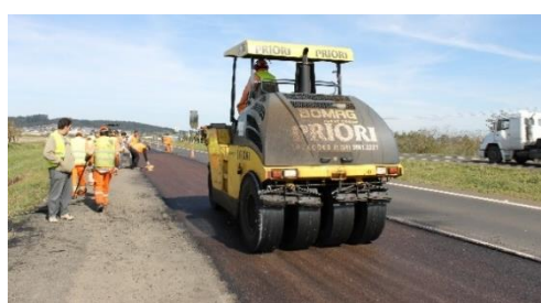
(d) Compactação com rolo pneu.
