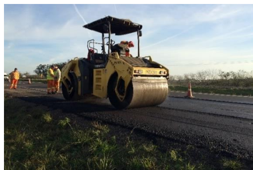
(f) Compactação do revestimento.
