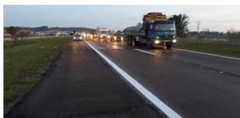
(f) Pintura de sinalização.
