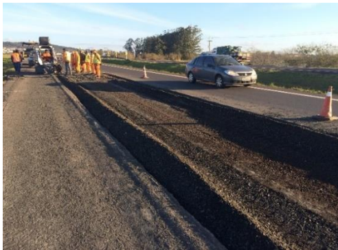
(a) Fresagem da camada de revestimento.
