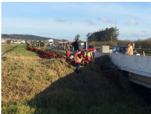
(e) Instalação da tubulação.
