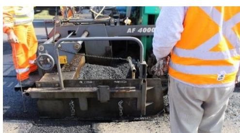
(c) Finalização da camada.
