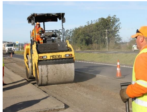
(d) Compactação da base.
