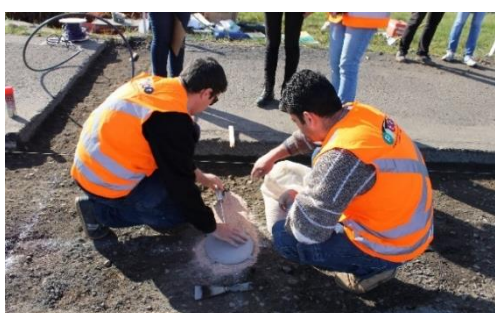
(e) Ajuste das células.
