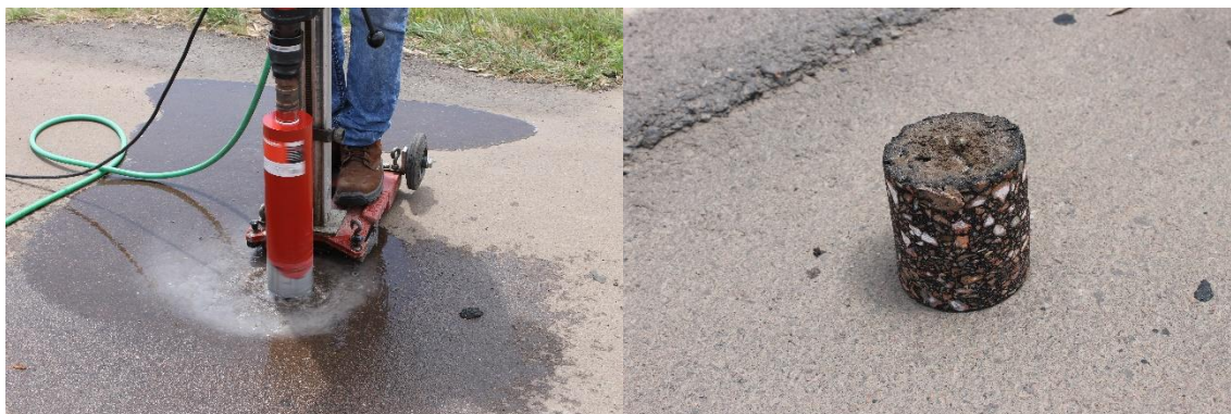
Figura 76 – Extração de corpos de prova cilíndricos do acostamento.
