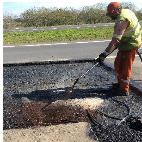
(f) Imprimação final no local dos sensores.
