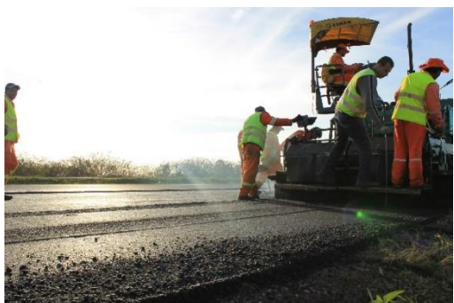
(e) Execução do revestimento.
