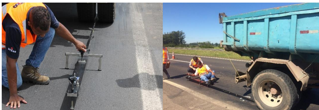
Figura 64 – Levantamento de campo com a viga Benkelman.
