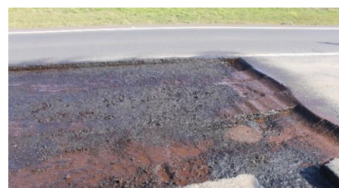
(h) Imprimação da camada de pó.
