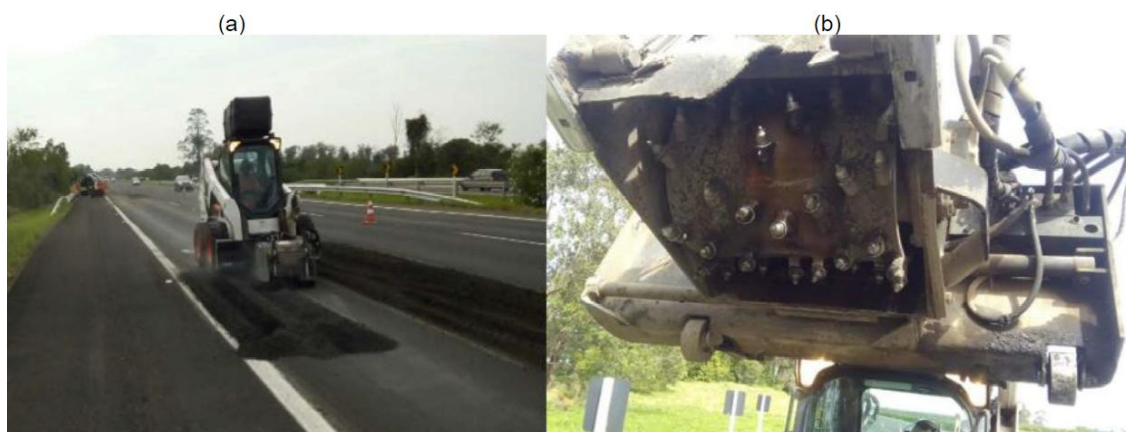
Figura 14: Equipamento realizando serviço de fresagem (a) e detalhe do tambor de fresagem (b) (LUZZI, 2019)
