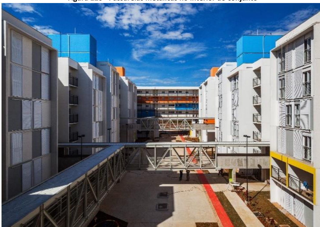
Figura 126 - Passarelas metálicas no interior do conjunto
