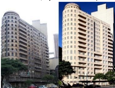
Figura 10 – Edifício Riachuelo (à esquerda, antes da reforma; à direita, após a reforma)
