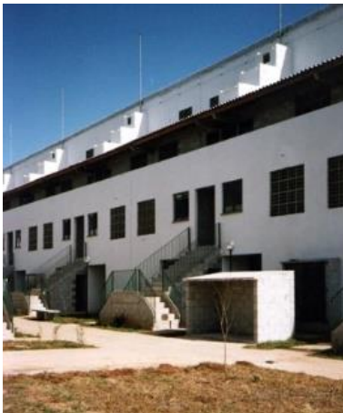
Figura 7 – Conjunto Habitacional Rio das Pedras
