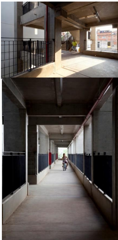
Figura 75 - Passarelas do Residencial Comandante Taylor mostrando os espaços de circulação e as instalações do edifício aparentes no teto e logo descendo no volume das escadas
