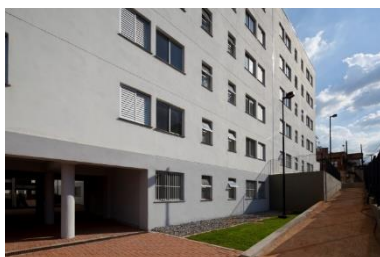
Figura 76 - Vista do acesso sob o edifício voltado para a Rua Visconde de Camamu
