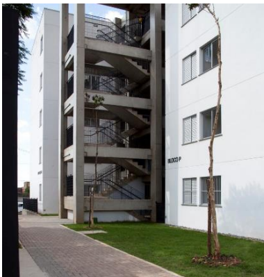
Figura 61 - Vista de uma das escadas
