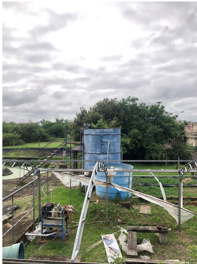
Figura 4.6 – Visão lateral do reator UASB presente na estação experimento de afluentes da Universidade Federal do Rio Grande do Sul
