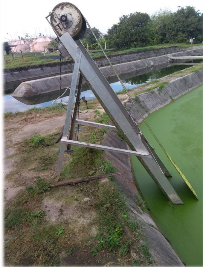
Figura 15 - Esteira mecânica para retirada de macrófitas flutuantes na ETE São João, Porto Alegre, RS.
