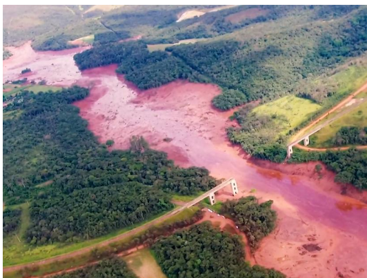
(a) Resultado do rompimento da barragem em Brumadinho/MG
