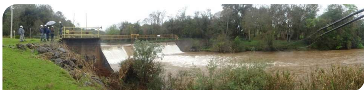
Figura 1: Barragem da PCH-Andorinhas.
