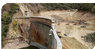
Figura 3 - Barragem de Malijita após o assoreamento
