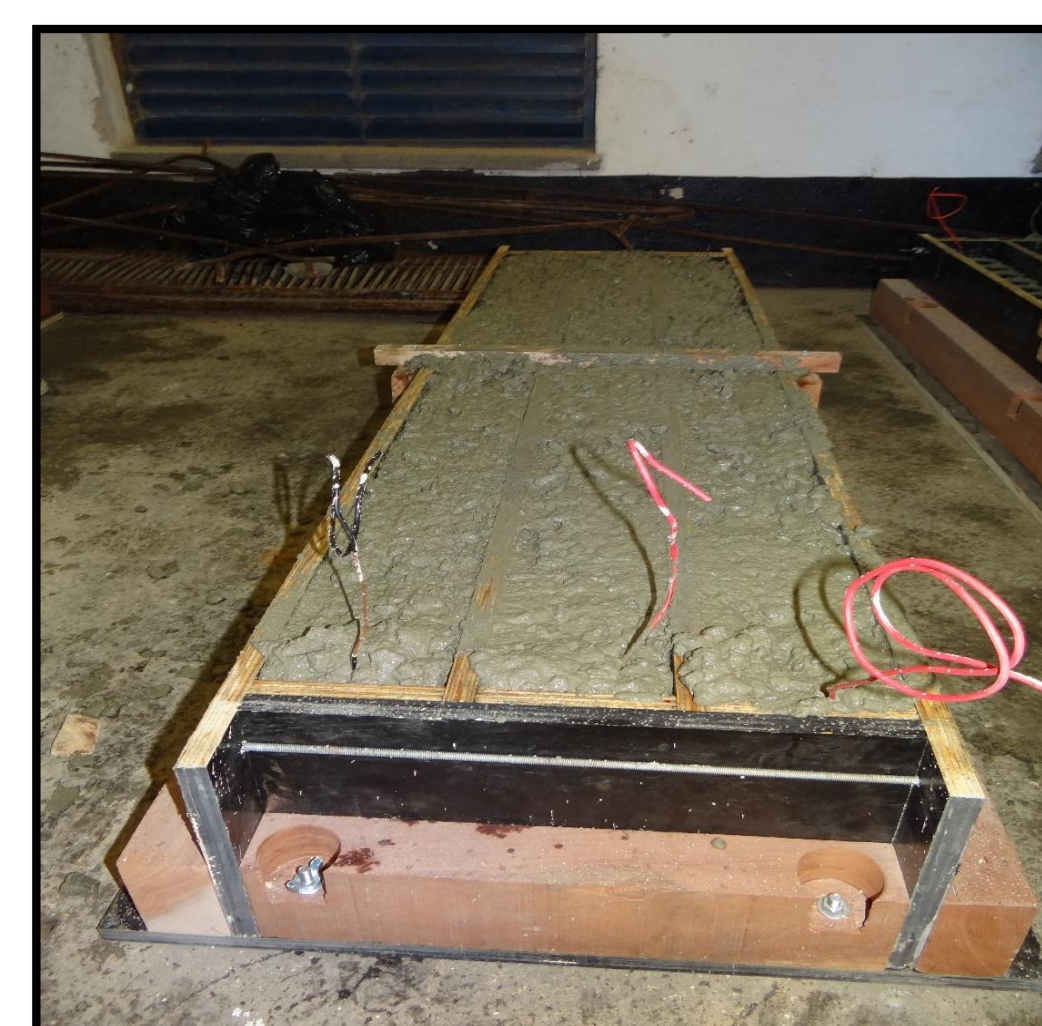
Concretagem das vigas
