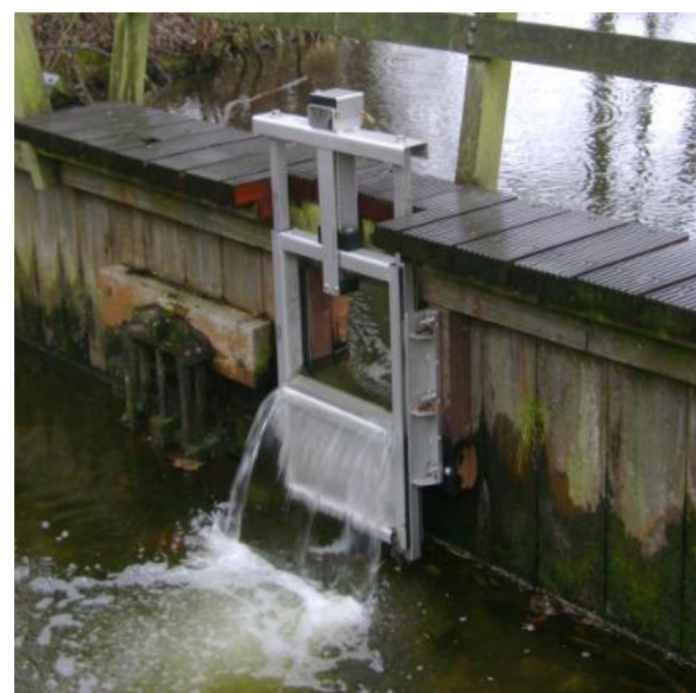
Vertedor de parede delgada em aplicação (HC, 2019).
