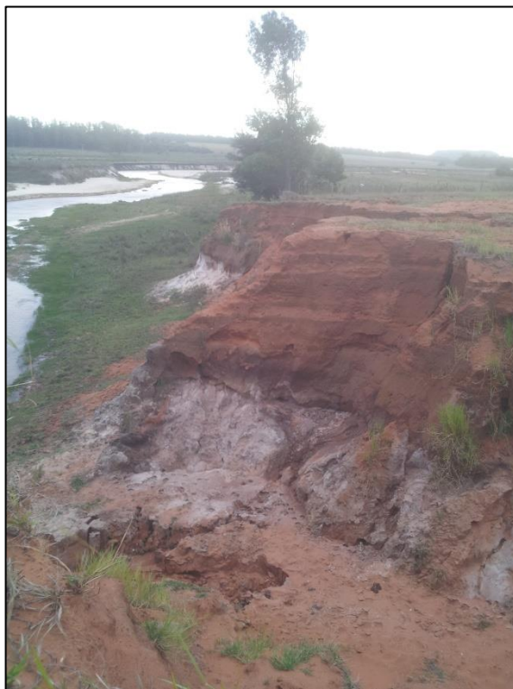
Figura 19: Talude com processo de ravinamento. Autora (2016).
