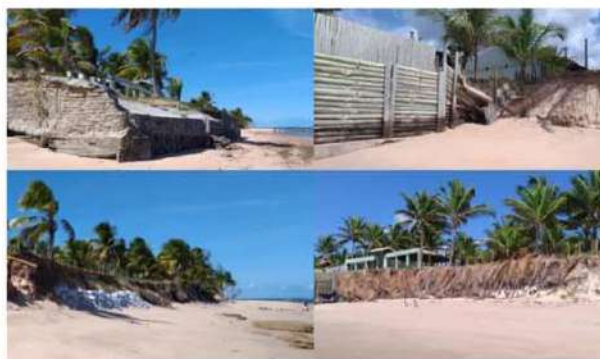
Figura 3. Soluções praticadas pelos proprietários dos terrenos em áreas de erosão costeira.
