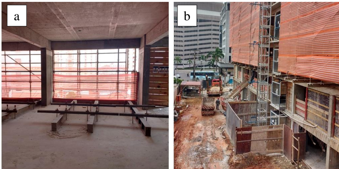
Figura 35 - Trilhos para instalação do andaime fachadeiro em balanço na obra B1
