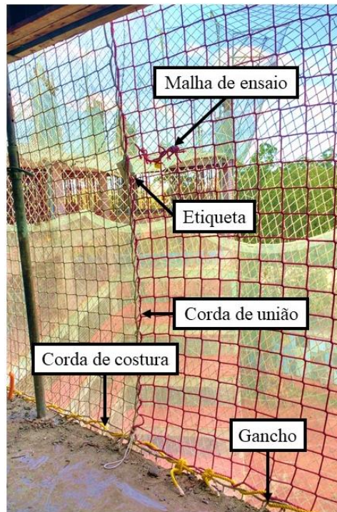
Figura 30 - Componentes do sistema U na obra A
