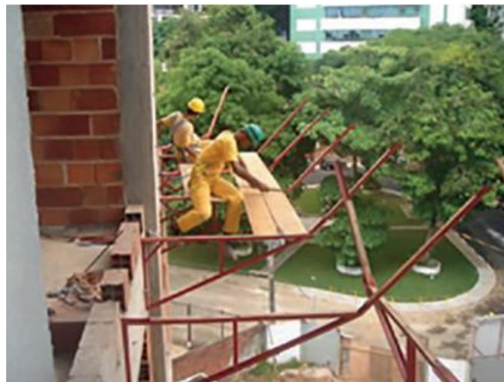
Figura 4 - Montagem de plataformas secundárias
