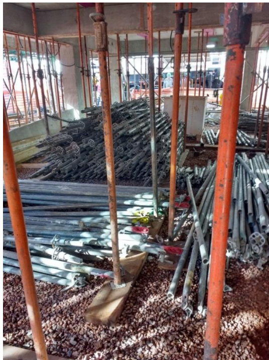
Figura 40 - Estoque de peças para o andaime fachadeiro da obra B2
