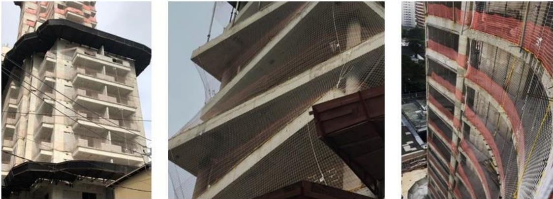
Figura 38 - Adaptação da rede U com diferentes fachadas
