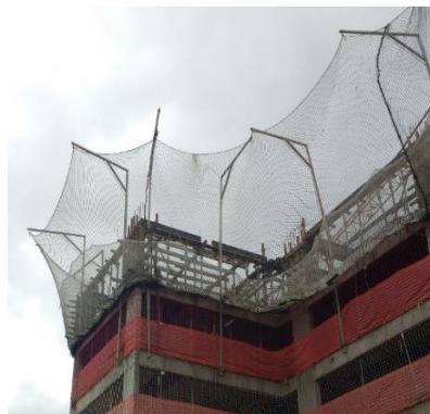
Figura 5 - Sistema Rede V em obra em Canoas-RS
