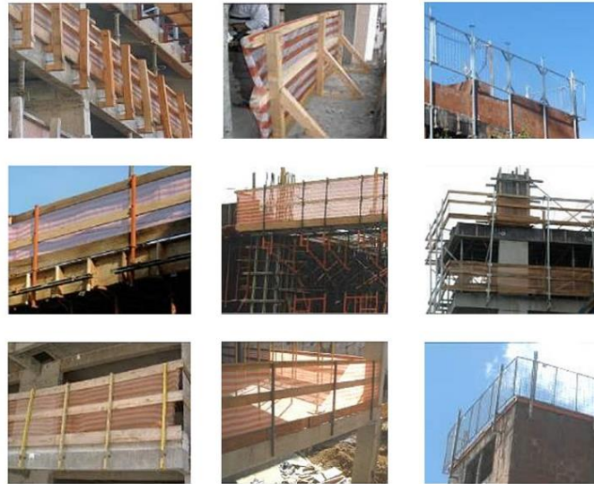
Figura 3 - Exemplos de sistemas de guarda-corpo e rodapé (GcR)
