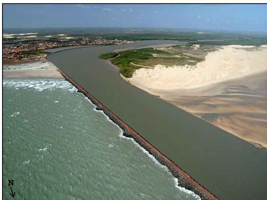
Figura 6. Desembocadura do rio Igarapé. O lado direito da fotografia mostra uma extensa acumulação de sedimentos arenosos, abrigados no interior da estrutura portuária. Do lado esquerdo, tem-se o efeito das ondas e a deriva litorânea associada sendo interrompida pelo molhe. Fonte: Koch, 2018.
