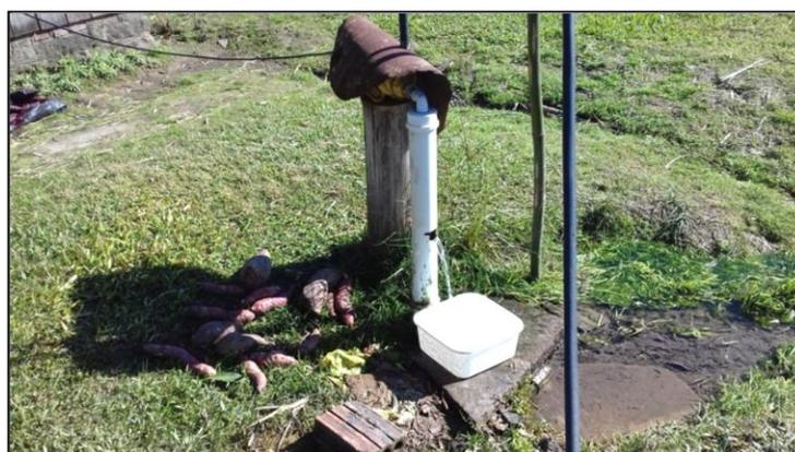
Figura 12. Poço de pequeno diâmetro com artesianismo, localizado na parte sul do município. Profundidade de 86m. Capta água da Formação Santa Maria, pertencente ao SAG.
