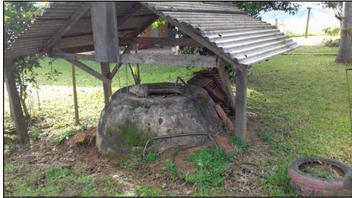
Figura 10. Poço escavado no pátio da casa de um morador. Capta água de um aquífero granular livre associado ao manto de alteração existente sobre as rochas sedimentares.
