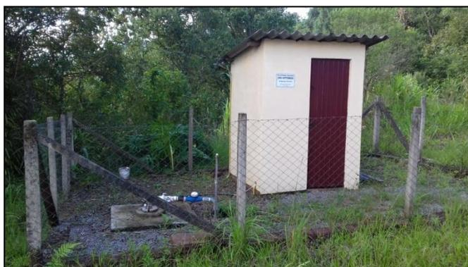
Figura 9. Poço tubular pertencente à Rede hídrica João Guttenberg, localizado na parte noroeste do município. Capta água do SASG.
