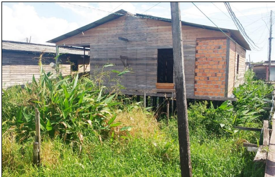
Figura 28 – Imóvel em construção na Ressaca do Tacacá com banheiro em alvenaria
