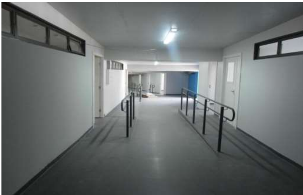
Foto 18 – Circulação de acesso às salas de aula no 11º andar Foto:Liska; Loder
