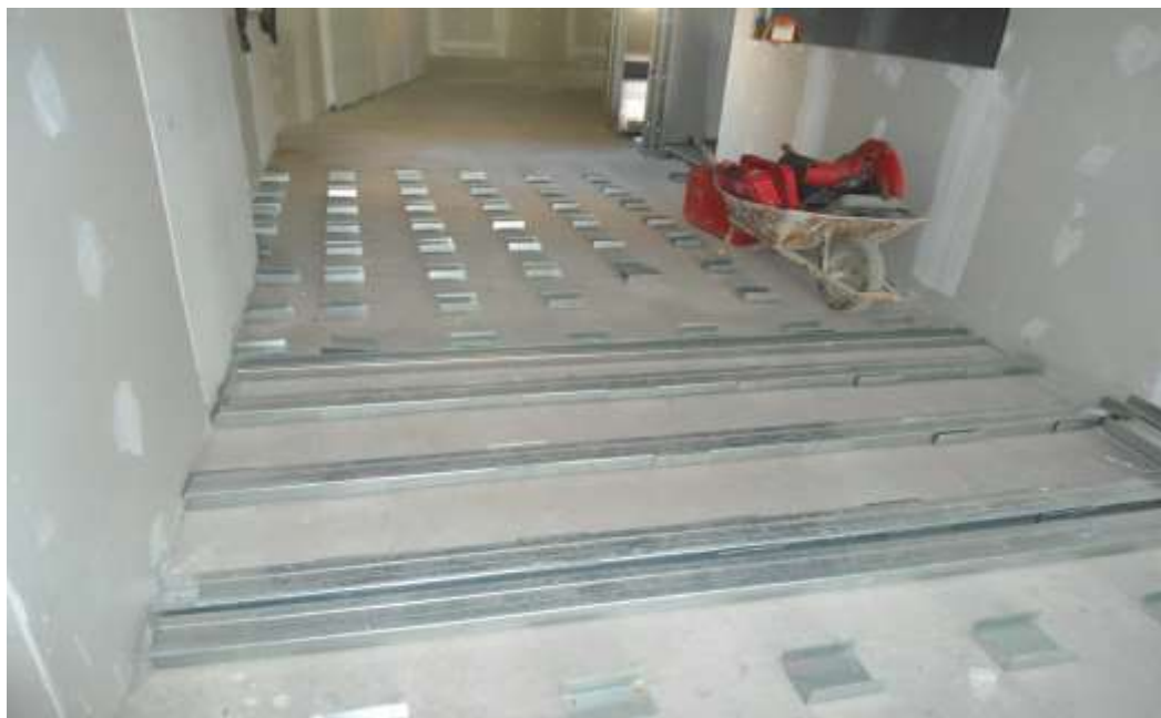
Foto 19 – Instalação Piso elevado no 10º andar Foto:Liska; Loder
