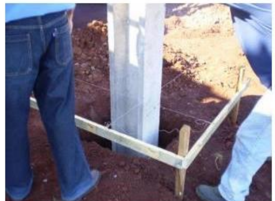
Fig. 88 – Processo de locação de um pilar de uma obra.
