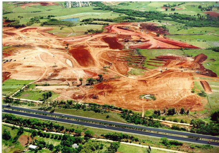
Fig. 108 Terraplenagem da GM em Gravataí
