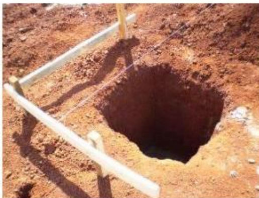
Fig. 88 – Processo de locação de um pilar de uma obra.
