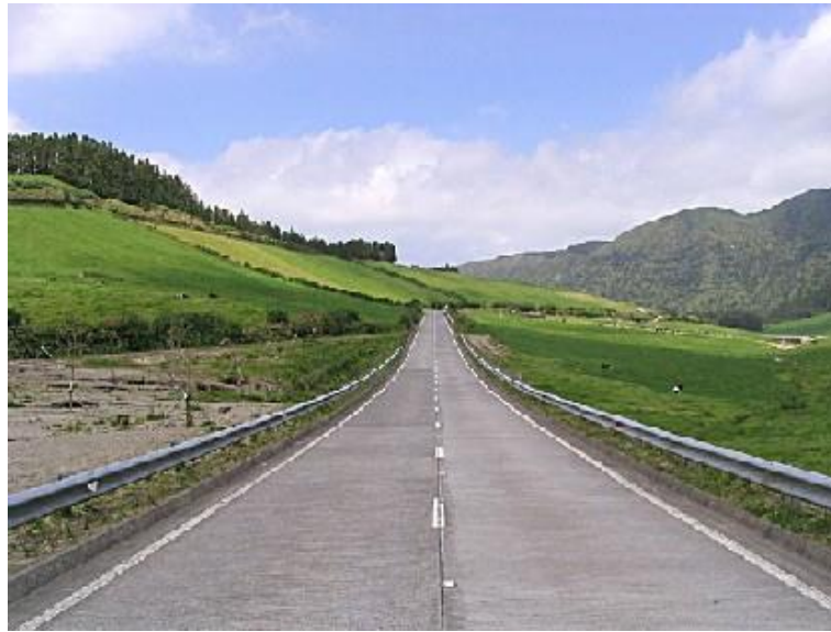
Fig. 47 – Curva Vertical Côncava
