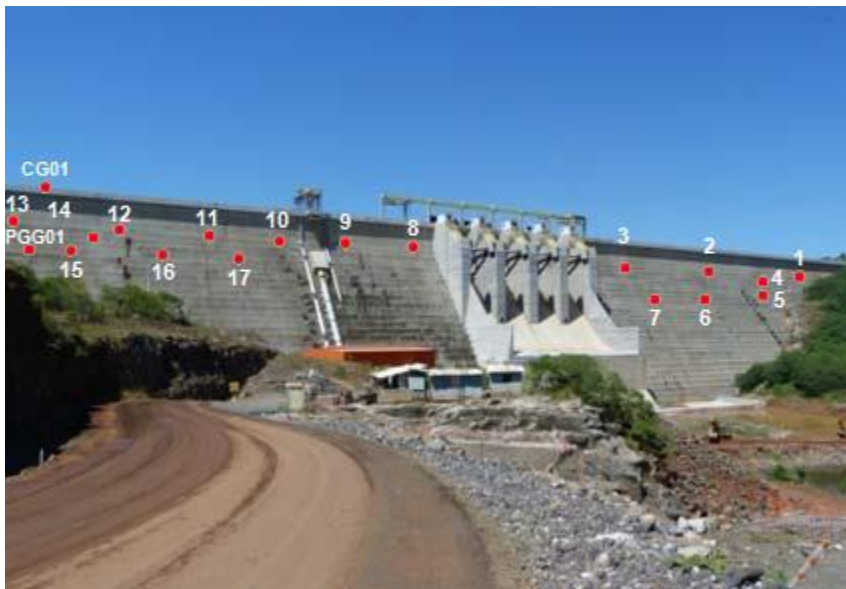
Fig. 67 – Posição das miras na frente da barragem
