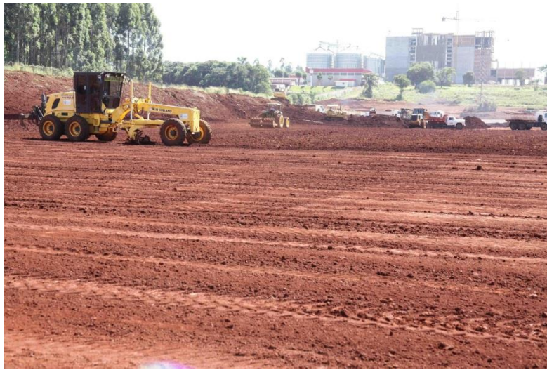
Fig. 107 – Terraplenagem de uma área
