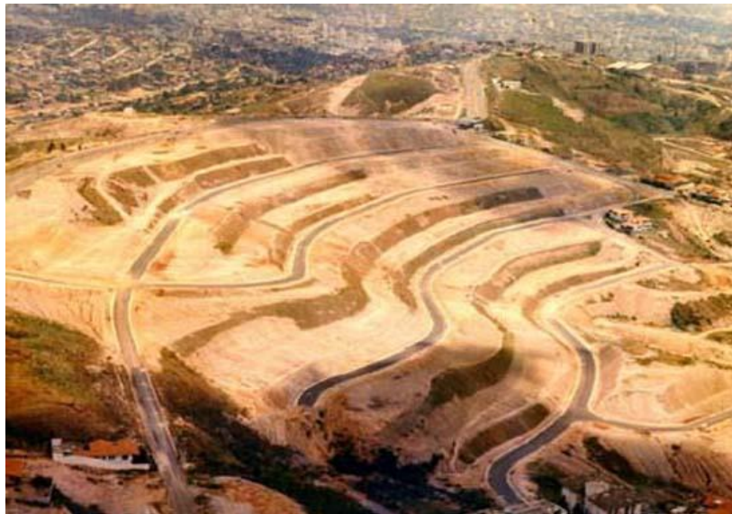
Fig. 110 Terraplenagem em degraus
