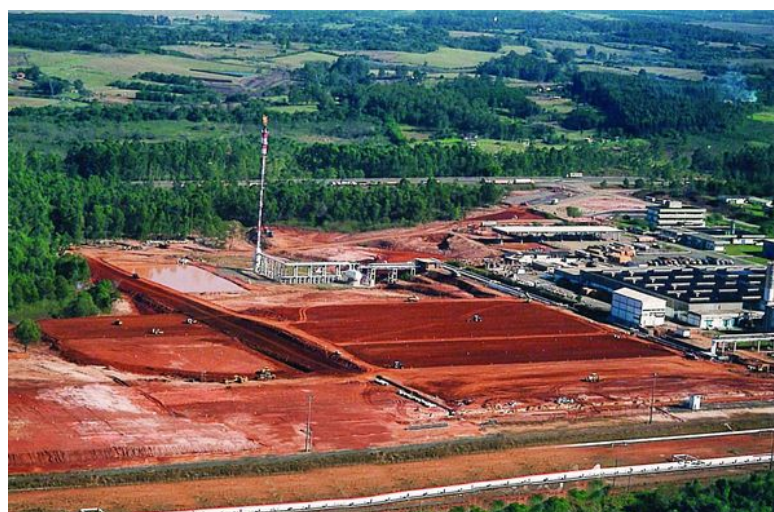
Fig. 109 Terraplenagem Polo Petroquímico - Triunfo
