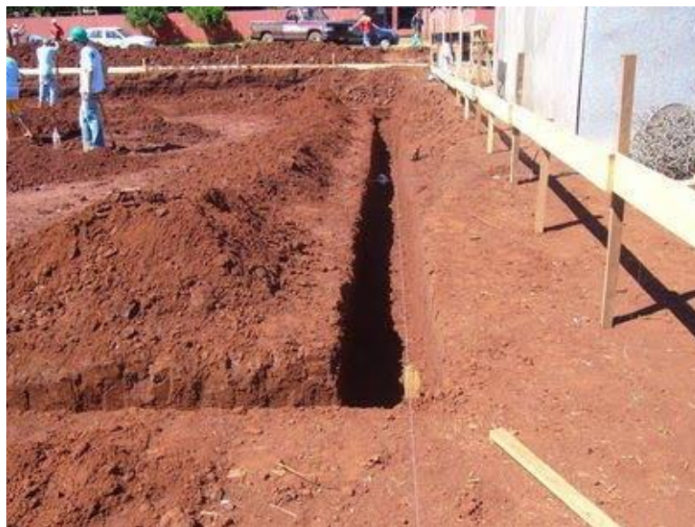
Fig. 96 – Locação da vala para a construção dos alicerces
