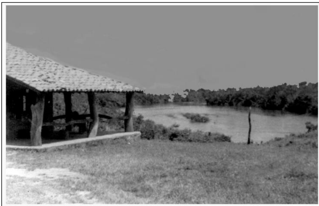
Figura 15 – Primeira casa construída em Xavantina, no mesmo lugar do acampamento pioneiro, ao fundo o Rio das Mortes:
