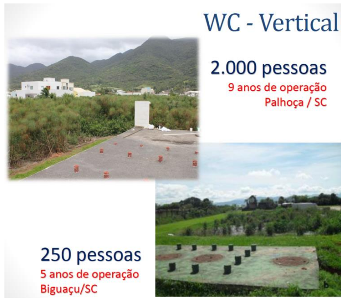
Figura 22 – Tecnologias alternativas de tratamento complementar: wetlands construídos.
