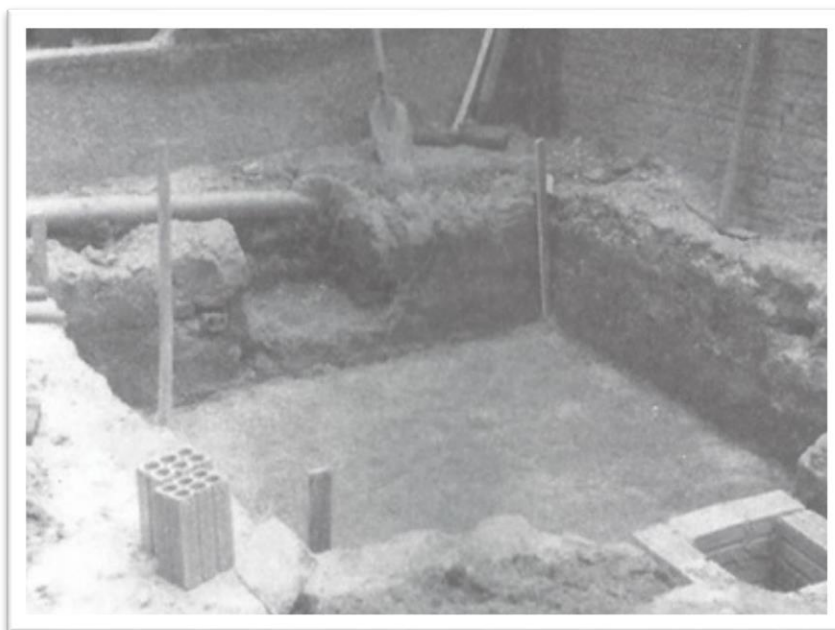
Figura 9 – Construção de filtro plantado com macrófitas diretamente no solo.
