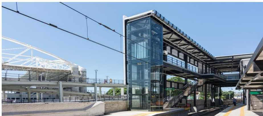
Figura 45 - Um dos novos acessos da estação Olímpica de Engenho de Dentro (Foto: LMartins fotografia)
