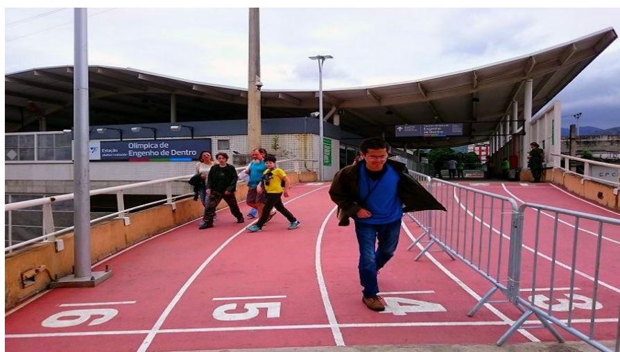
Figura 47 - Pista estilizada na estação Olímpica de Engenho de Dentro 186
