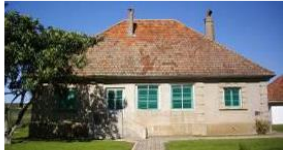
FIGURA 15.53: Fachada Principal. Fonte: BRAGHIROLI, 2014, p.312.
