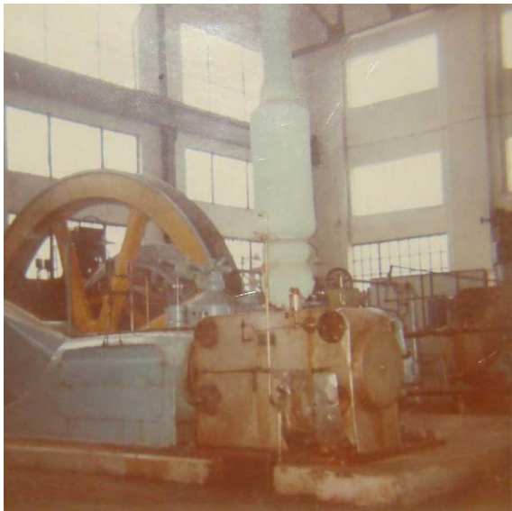
FIGURA 11.15: Compressores de Amônia, movidos à vapor. Acervo: Ivonil Gonzales. 1973.
