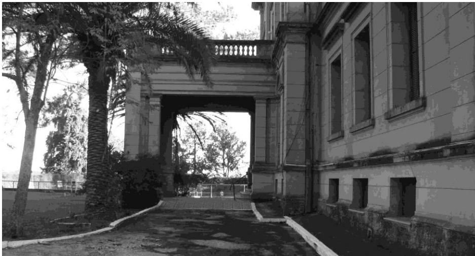
FIGURA 14.35: Pórtico de entrada. Fonte: Acervo do Autor, 14 jun 2015.
