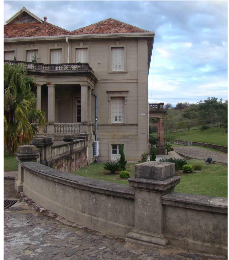
FIGURA 14.03: Prédio da Administração. Fonte: Acervo do Autor, 13 jun 2015.
