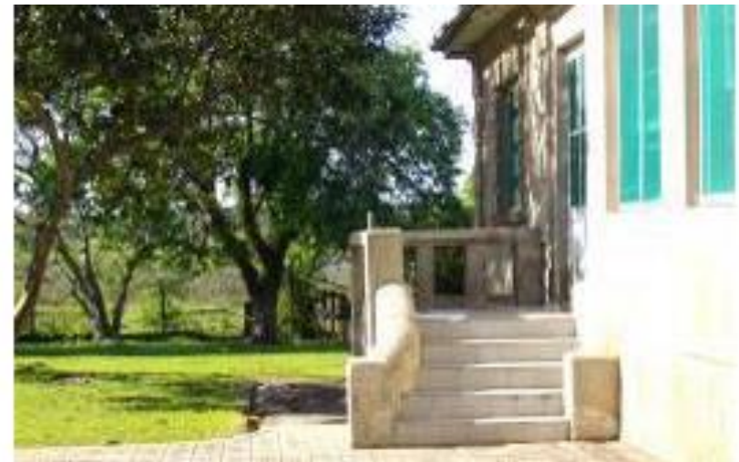
FIGURA 15.54: Casa D. Escada de acesso. Fonte: BRAGHIROLI, 2014, p.312.
