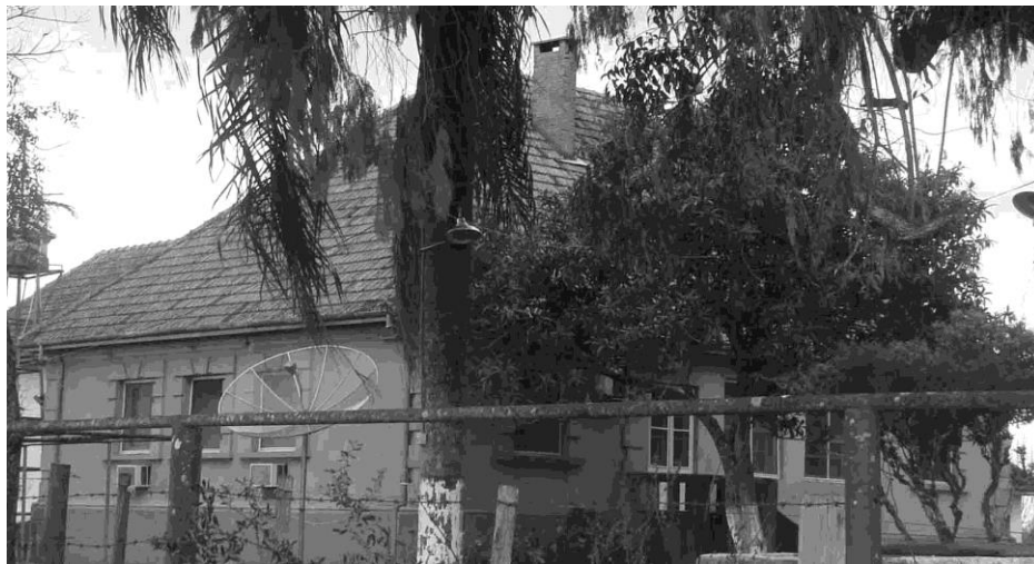
FIGURA 15.48: Fachadas norte e oeste. Fonte: Acervo do Autor. Data: 05 jul 2017.
