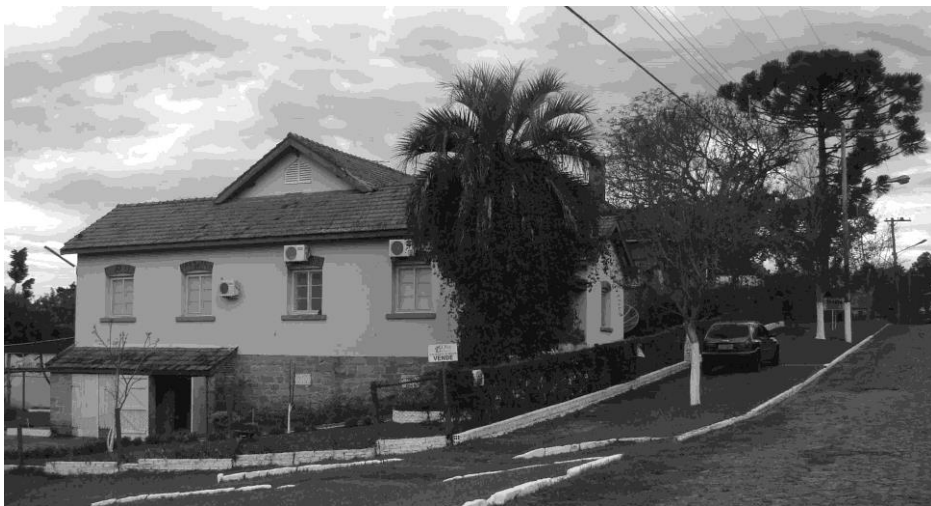
FIGURA 15.76: Fachada norte. Fonte: Acervo do Autor, 13 jun 2015.
