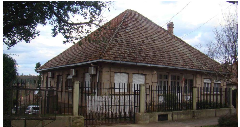
FIGURA 15.41: Fachadas norte e oeste. Fonte: Acervo do Autor, 13 jun 2015.
