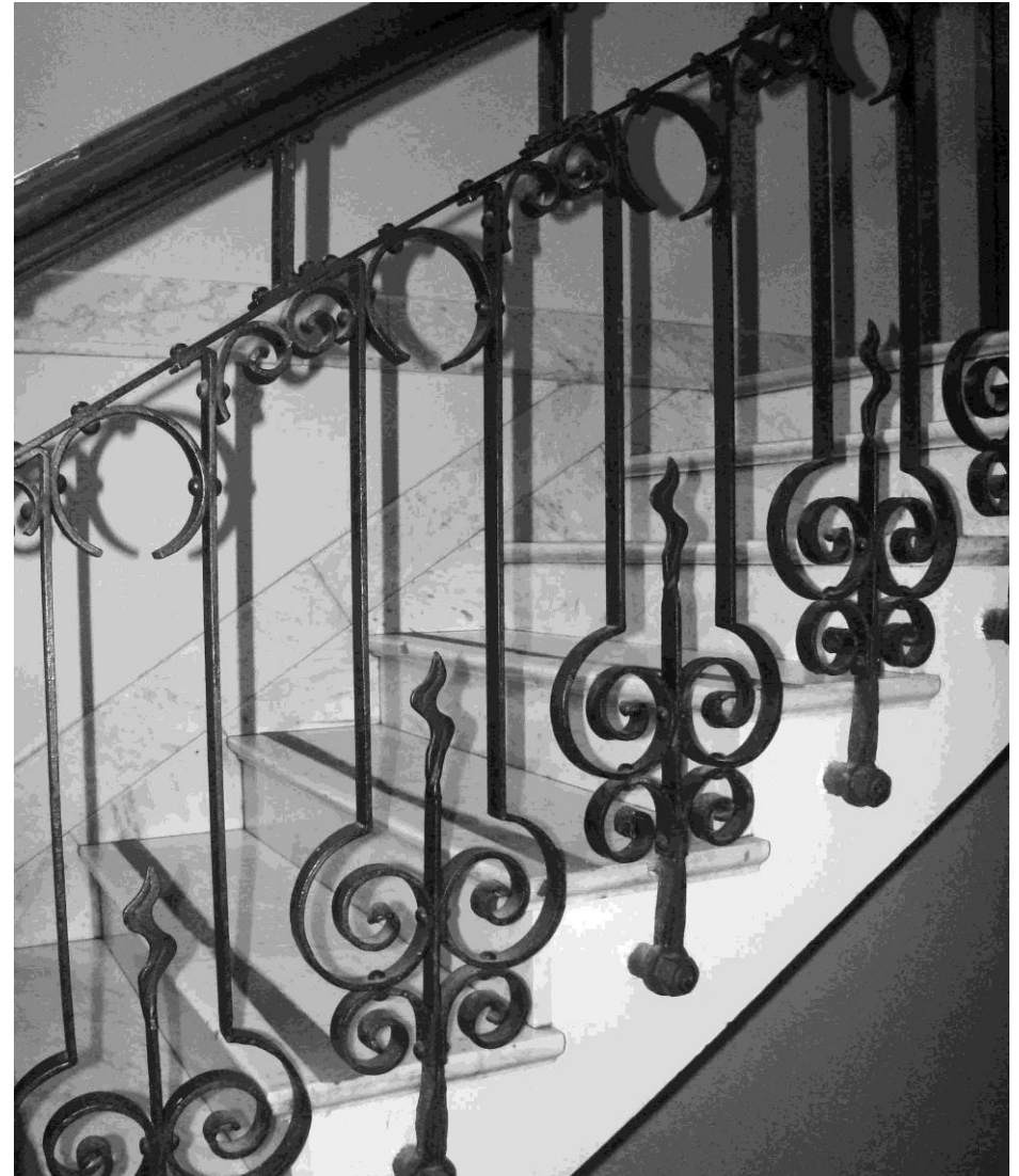
FIGURA 14.10: Detalhe guarda-corpo. Fonte: Acervo do Autor, 26 fev 2018.
