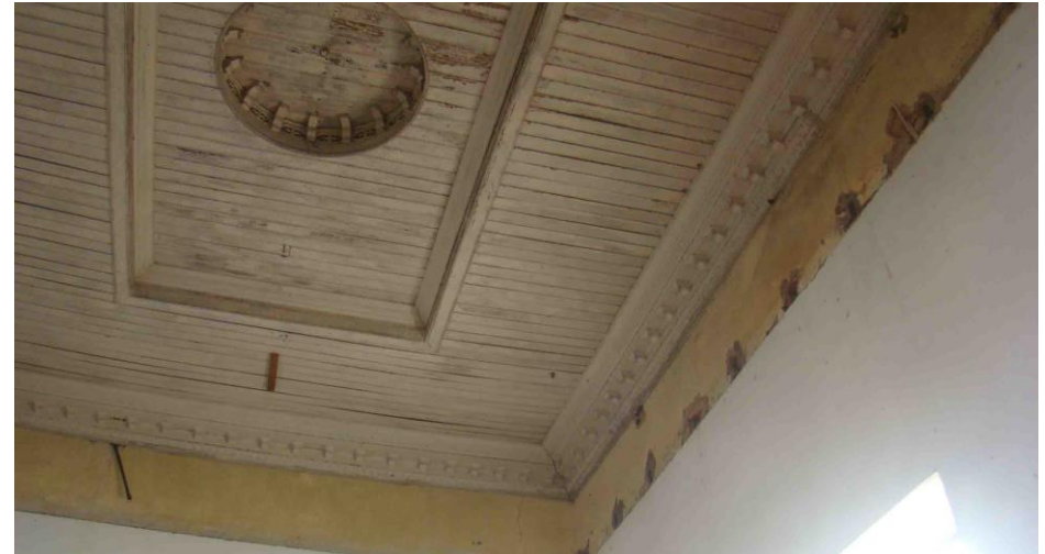
FIGURA 05.22: Detalhe do forro. Fonte: Acervo do autor, 05 jul 2017.
