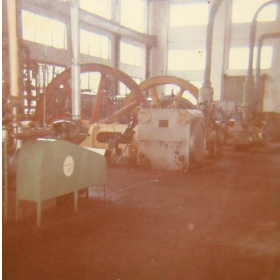
FIGURA 11.14: Compressores de Amônia, movidos à vapor. Acervo: Ivonil Gonzales. 1973.
