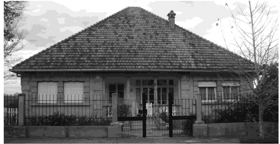
FIGURA 15.40: Fachada oeste. Fonte: Acervo do Autor, 13 jun 2015.
