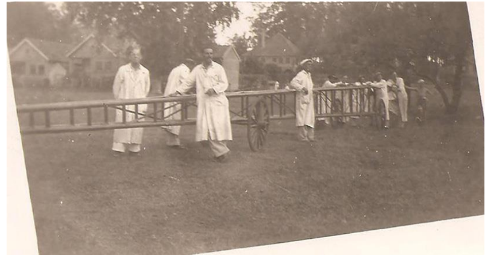
FIGURA 16.05: Instalação das torres de iluminação. Fonte: https://goo.gl/AGQ8sl . Acesso: 13 fev 2017.
