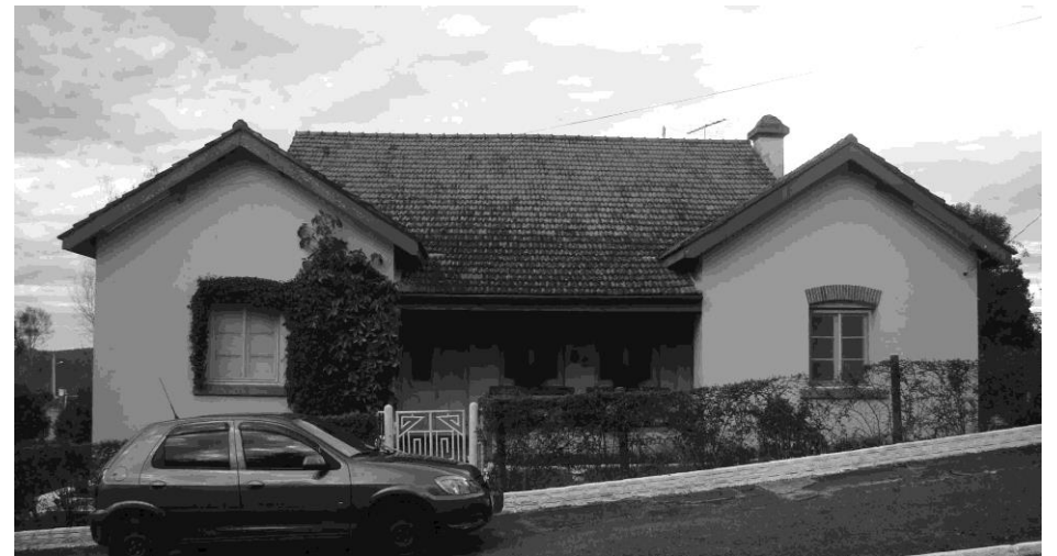
FIGURA 15.78: Fachada oeste. Fonte: Acervo do Autor, 13 jun 2015.
