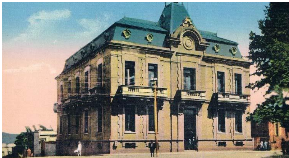
FIGURA 03.12: Prefeitura Municipal. Fonte: https://goo.gl/BJsx9n . Acesso: 27 abr 2017.
