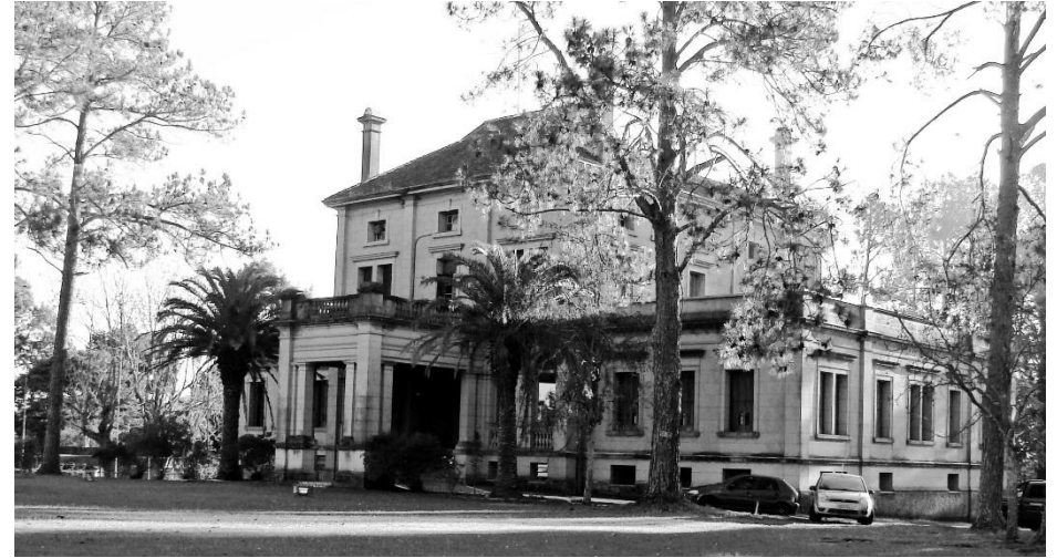
FIGURA 14.36: Fachada sul. Fonte: Acervo do Autor, 14 jun 2015.
