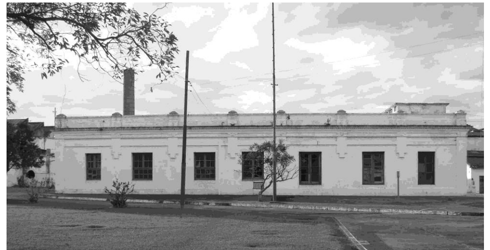
FIGURA 05.15: Fachada sul. Fonte: Acervo do autor, 13 jun 2015.
