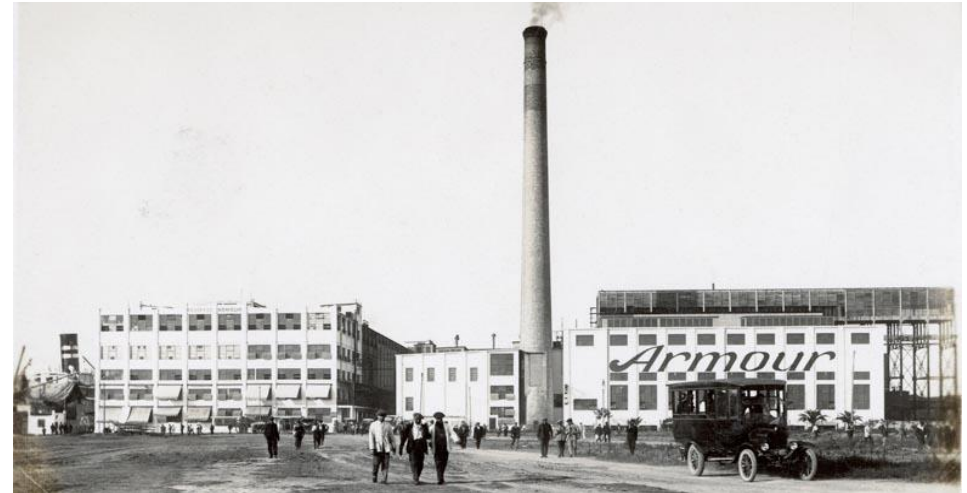
FIGURA 08.14: Armour Berisso, La Plata, Argentina. Fonte: https://goo.gl/iMGtXM . Acesso: 02 dez 2016.
