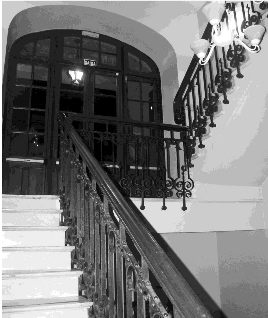
FIGURA 14.09: Escadaria lateral. Fonte: Acervo do Autor, 26 fev 2018.
