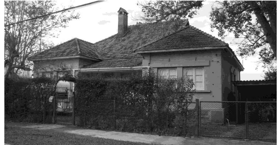
FIGURA 15.68: Fachada oeste. Fonte: Acervo do Autor, 13 jun 2015.
