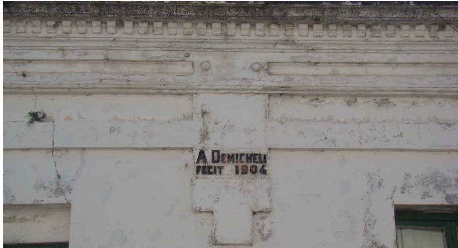
FIGURA 05.20: Detalhe da fachada leste. Fonte: Acervo do autor, 05 jul 2017.
