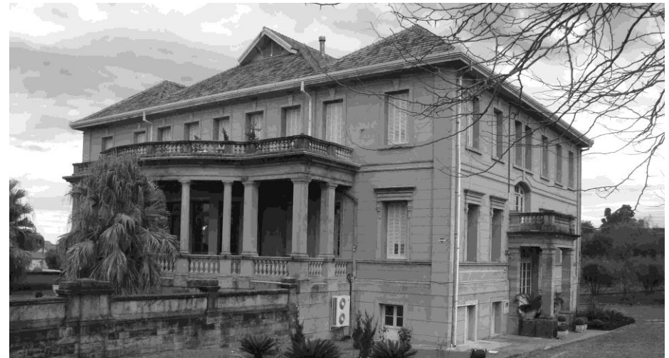
FIGURA 14.05: Fachada principal. Fonte: Acervo do Autor, 13 jun 2015.
