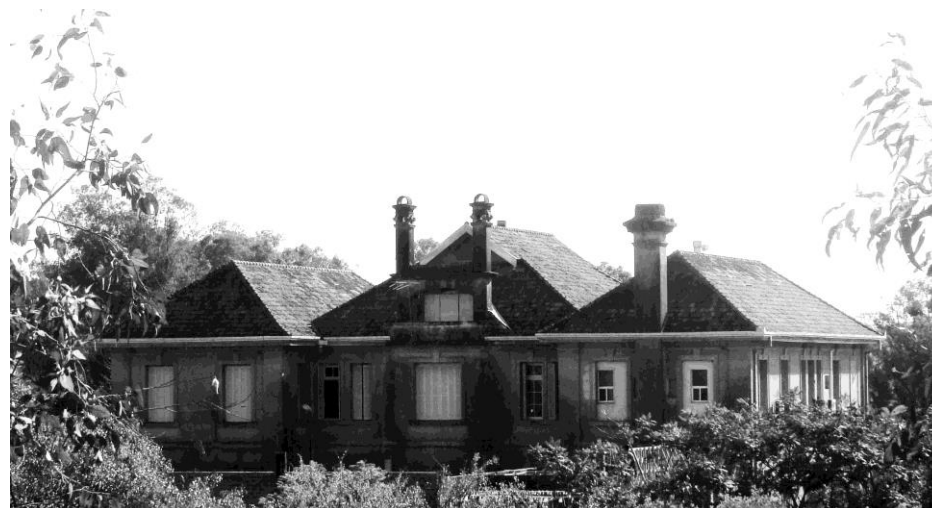
FIGURA 14.07: Detalhe superior da fachada sul. Fonte: Acervo do Autor, 04 jul 2017.
