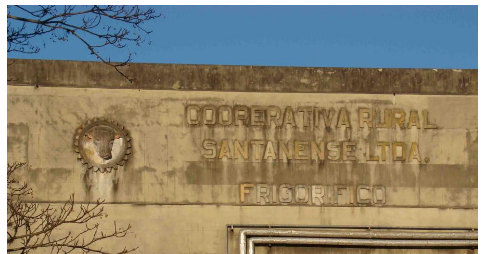
FIGURA 17.15: Detalhe fachada. Fonte: Acervo do Autor. 14 jun 2015.
