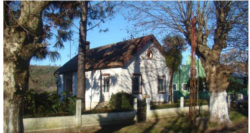
FIGURA 15.103: Casa unifamiliar. Fonte: Acervo do Autor, 03 jul 2017.
